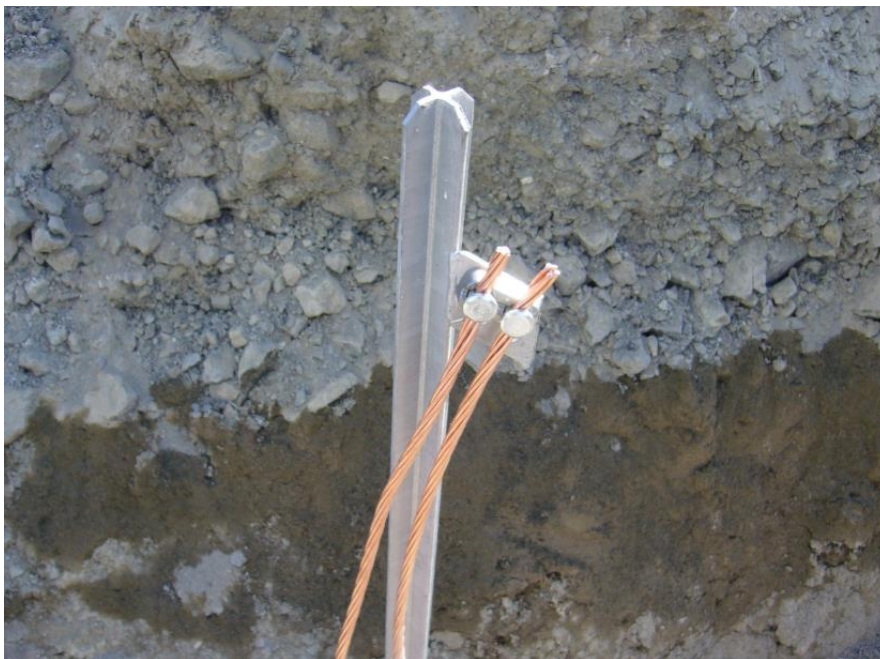
Figura 21 – Esempio di impianto di messa a terra con picchetti dispersori
