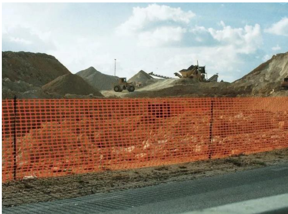
Figura 15 – Tipologico recinzione aree di lavorazione
