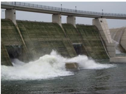
Le manovre alle paratoie vengono effettuate, con sistemi tecnologici, da una centrale posta a fianco della diga, ma possono essere comandate anche a distanza.
