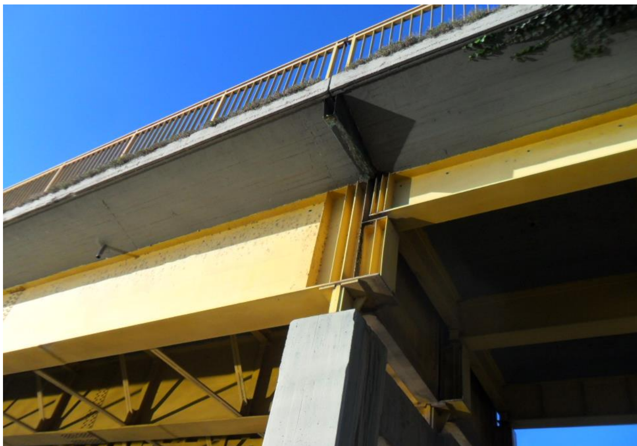
Figura 4 – Dettaglio di appoggio della campata di riva
