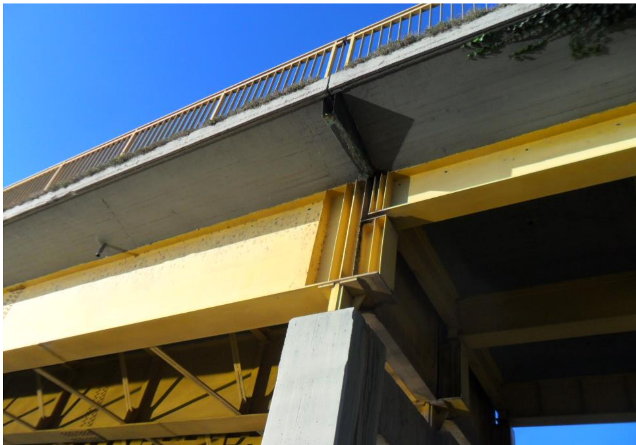
Figura 4 – Dettaglio di appoggio della campata di riva
