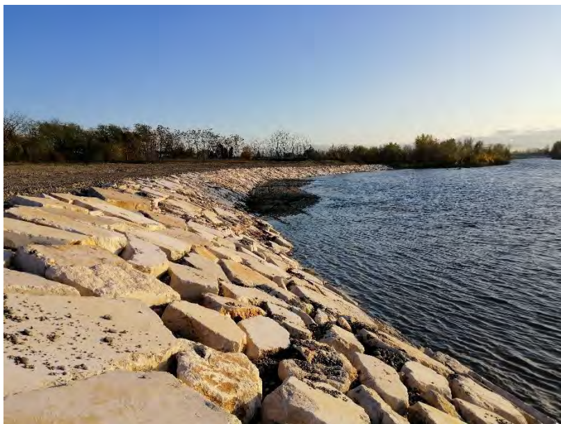
Figura 13 Vista fotografica della scogliera in massi a seguito del ripristino dell'erosione della sponda destra a monte della briglia selettiva
