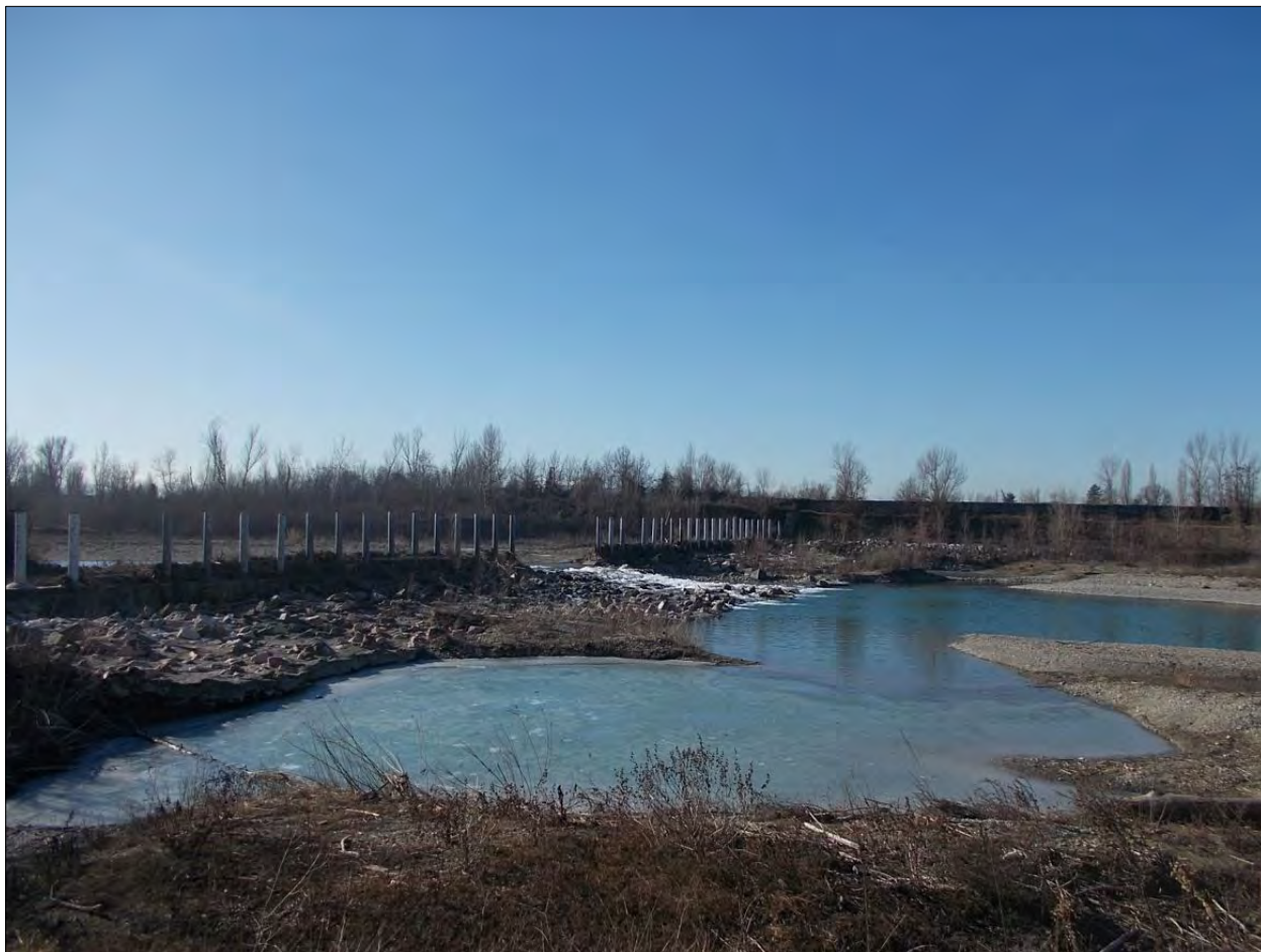
Figura 2-6 Scalzamento al piede della briglia selettiva
