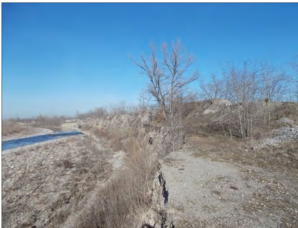
Figura 2-3 Incisione del fiume Panaro a monte della briglia selettiva, in destra idrografia
