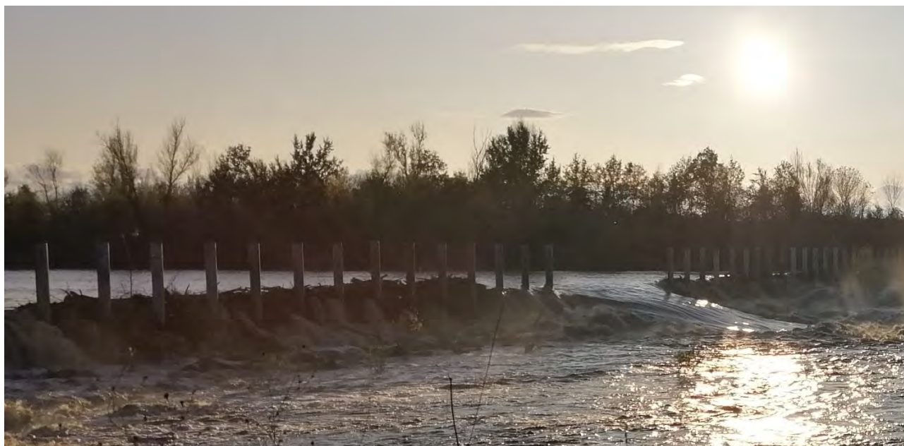
Figura 36 Vista da valle dell'intasamento del pettine di trattenuta della briglia selettiva durante l'evento del 17/11/2019
