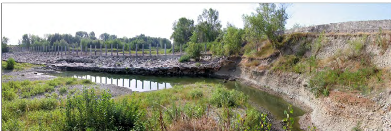
Figura 2-7 Erosione lungo la sponda in sinistra idrografica e scalzamento al piede a valle della briglia selettiva
