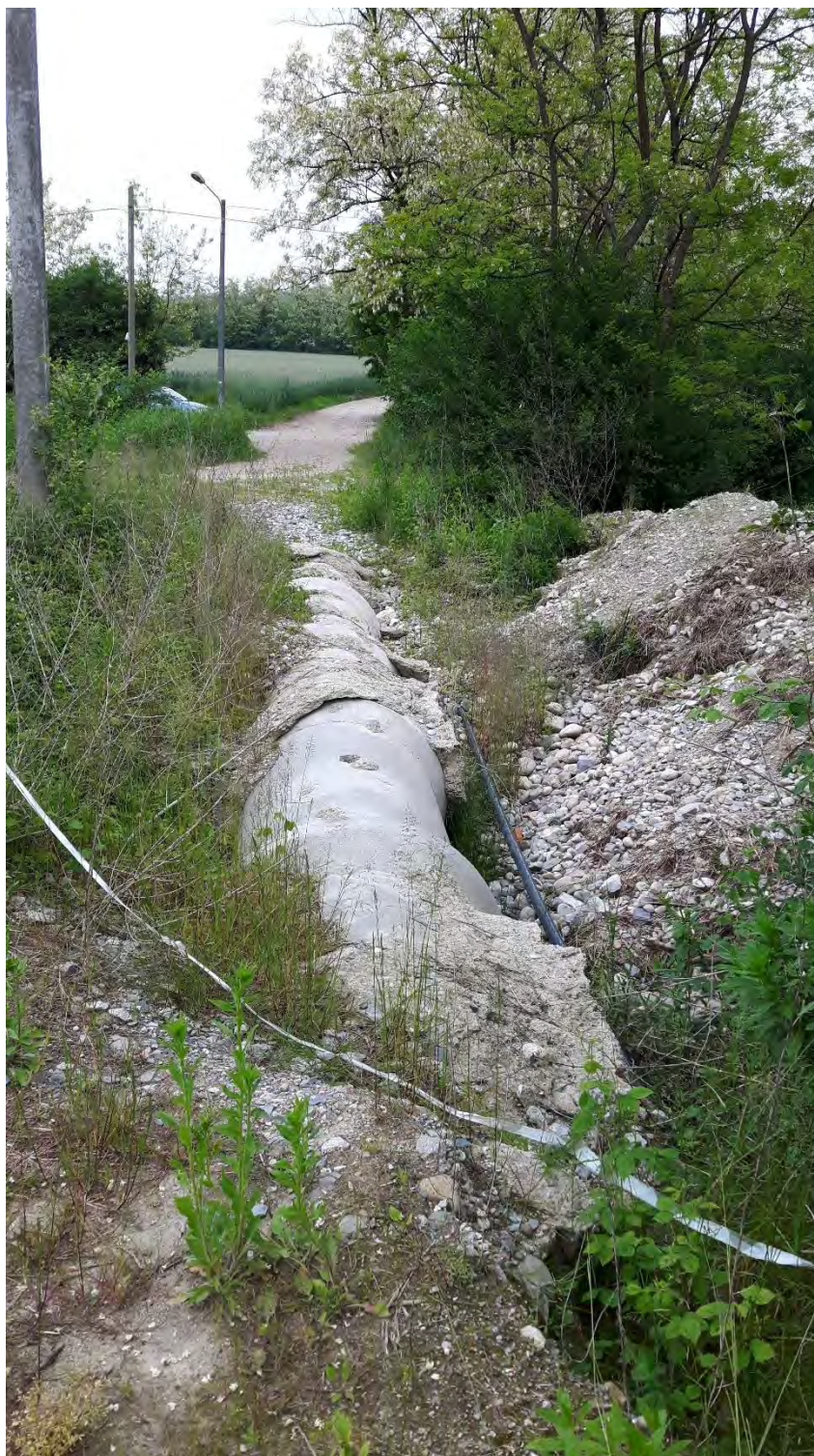
Figura 4: tubazione scoperta lungo Via dell'Abbazia
