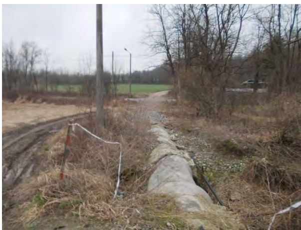
Figura 29 – particolare della condotta di troppo pieno scoperta sotto via dell'Abbazia
