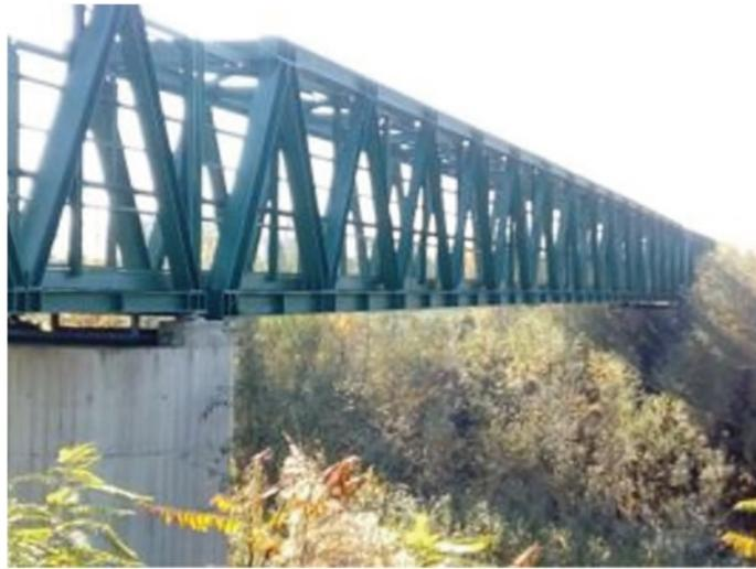
**Fig. 53** Vista da valle del ponte pedonale tipo Bailey
