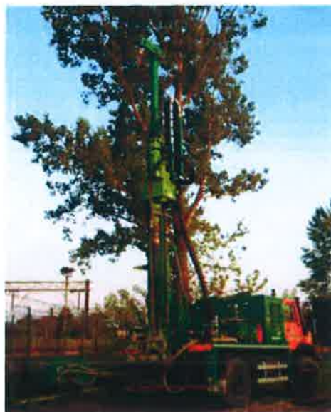
Particolare fotografico della sonda COMACCHIO su autocarro Unimog
