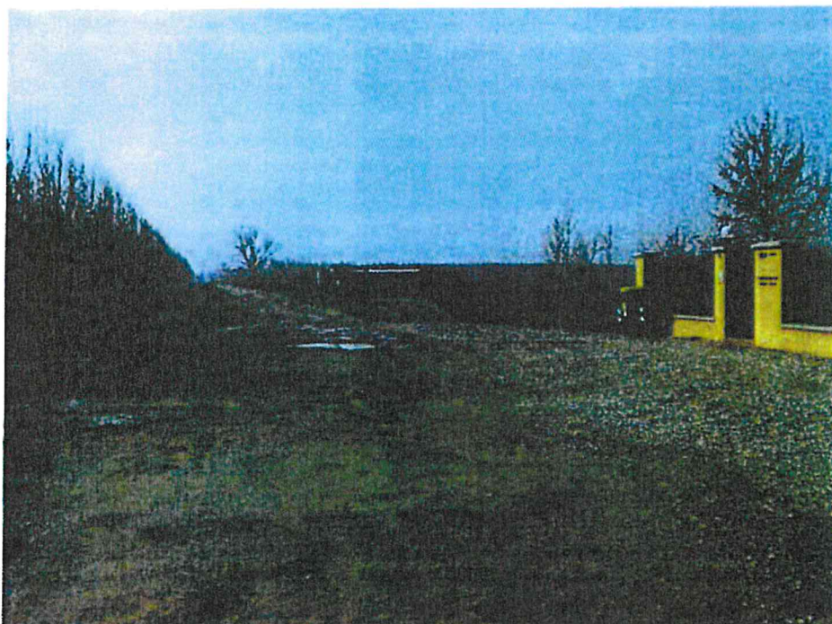
Foto 4: vista, verso monte, del tratto finale di innesto ("vecchio-nuovo")
