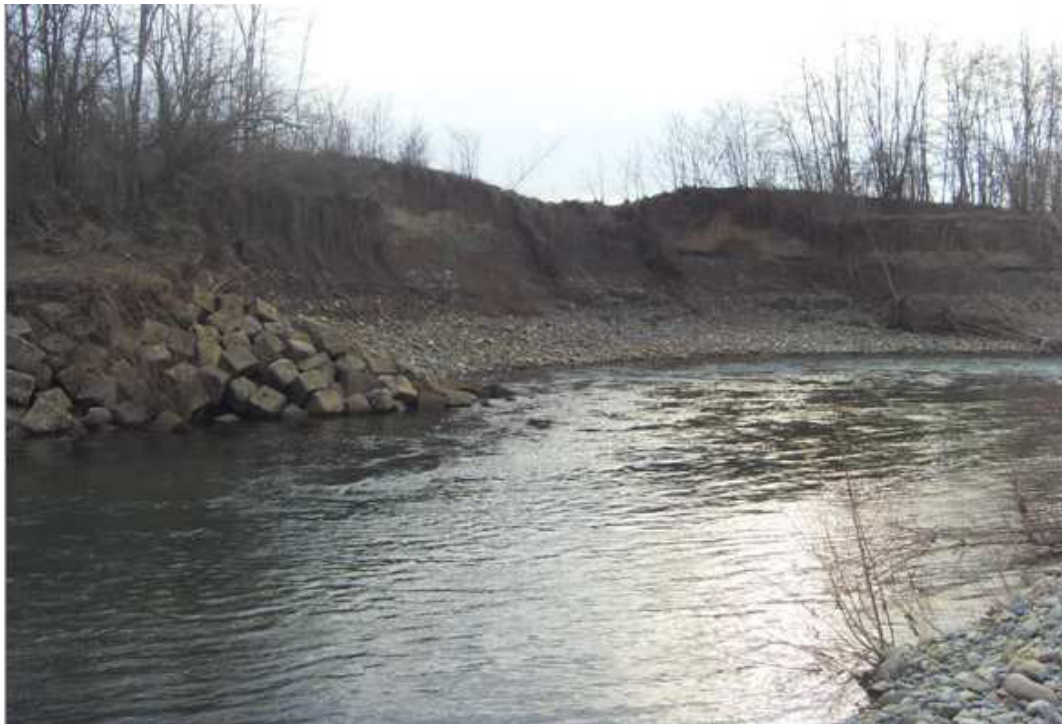
Fig. 3 Torrente Orba, sez. 12; particolare dell'asportazione della difesa di sponda e del collasso del paramento dell'argine retrostante ( area di intervento )
