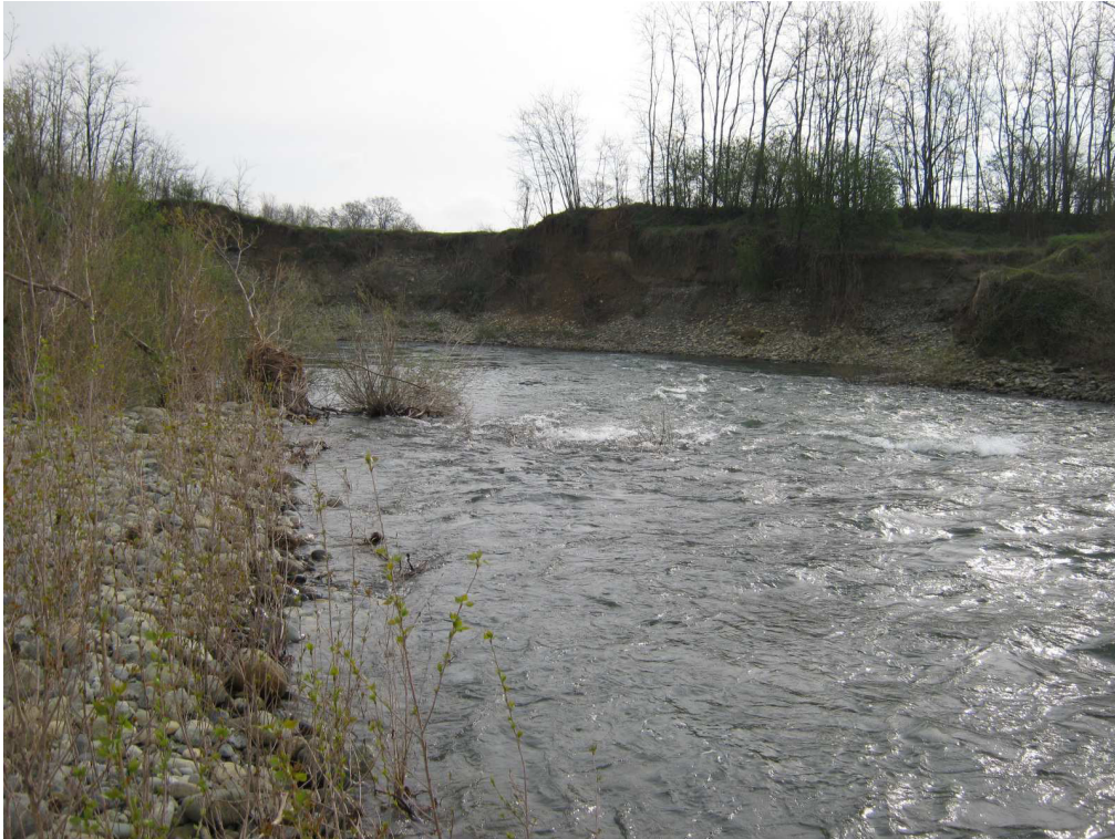
(Torrente Orba: vista da monte della lunata di erosione in sponda dx)
