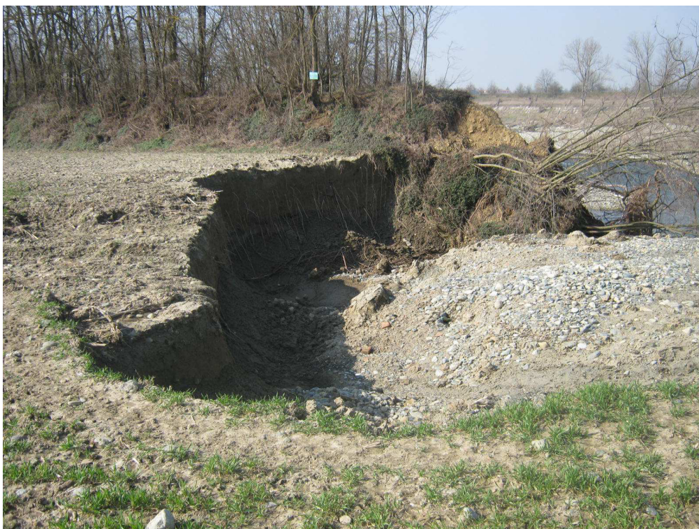
(Torrente Orba: erosione sulla sommità spondale a ridosso della lunata di erosione in dx idraulica)
