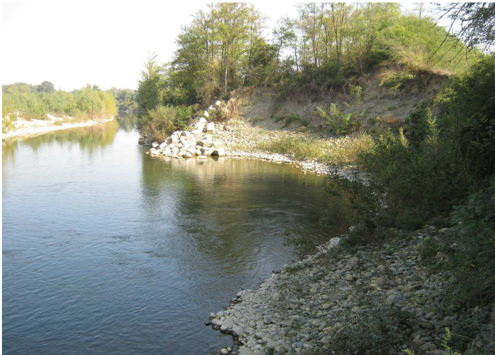
(Torrente Orba: vista da monte della lunata di erosione in sponda dx)
