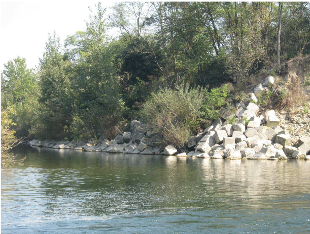
(Torrente Orba: mantellata esistente appena a valle della lunata di erosione)
