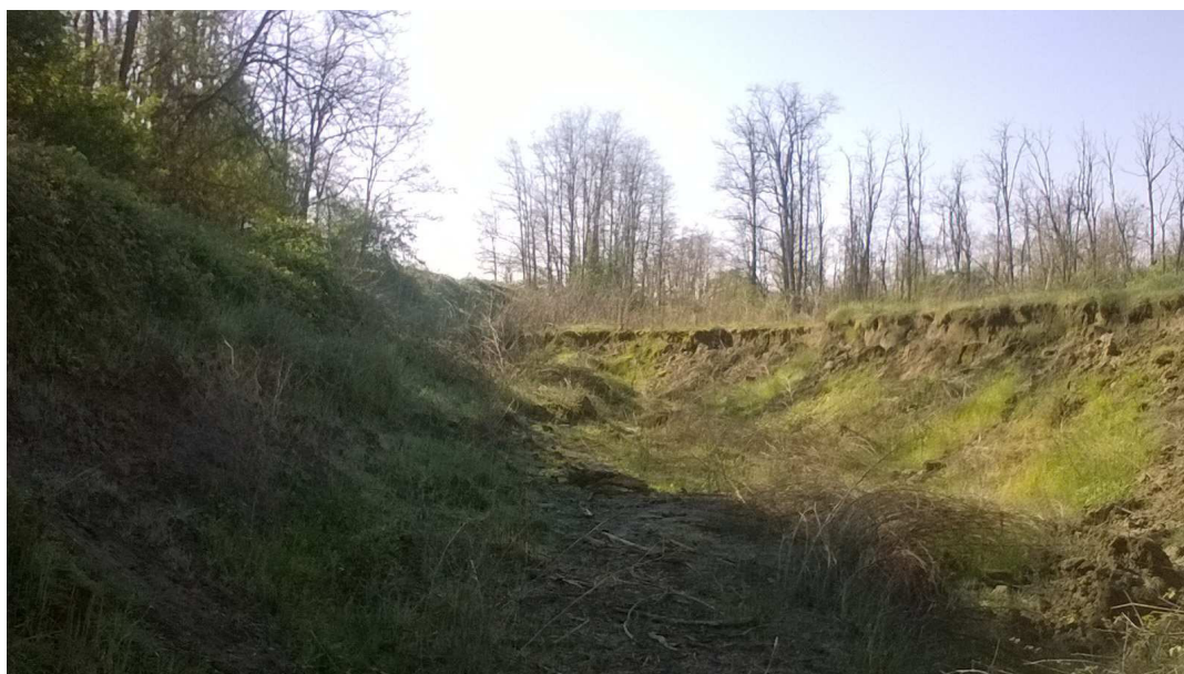
(Torrente Orba: erosione successivamente formatasi nella zona di monte sulla sommità del terrazzo superiore al piede dell'argine in dx idraulica)
