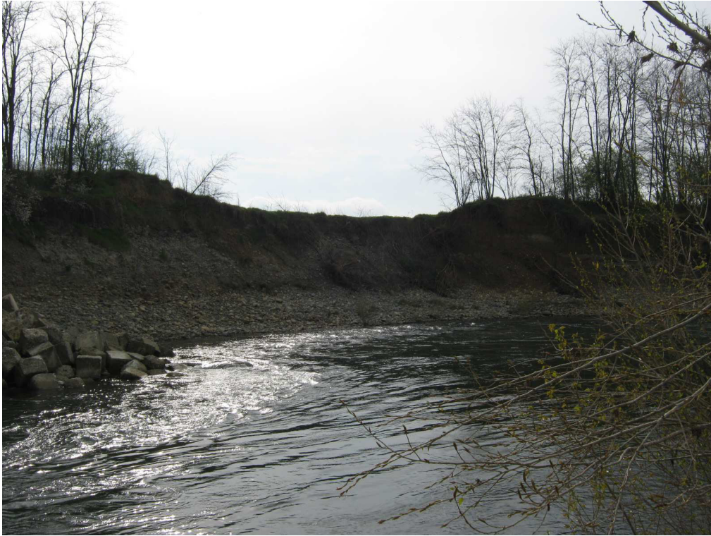
(Torrente Orba: vista da valle della lunata di erosione in sponda dx)
