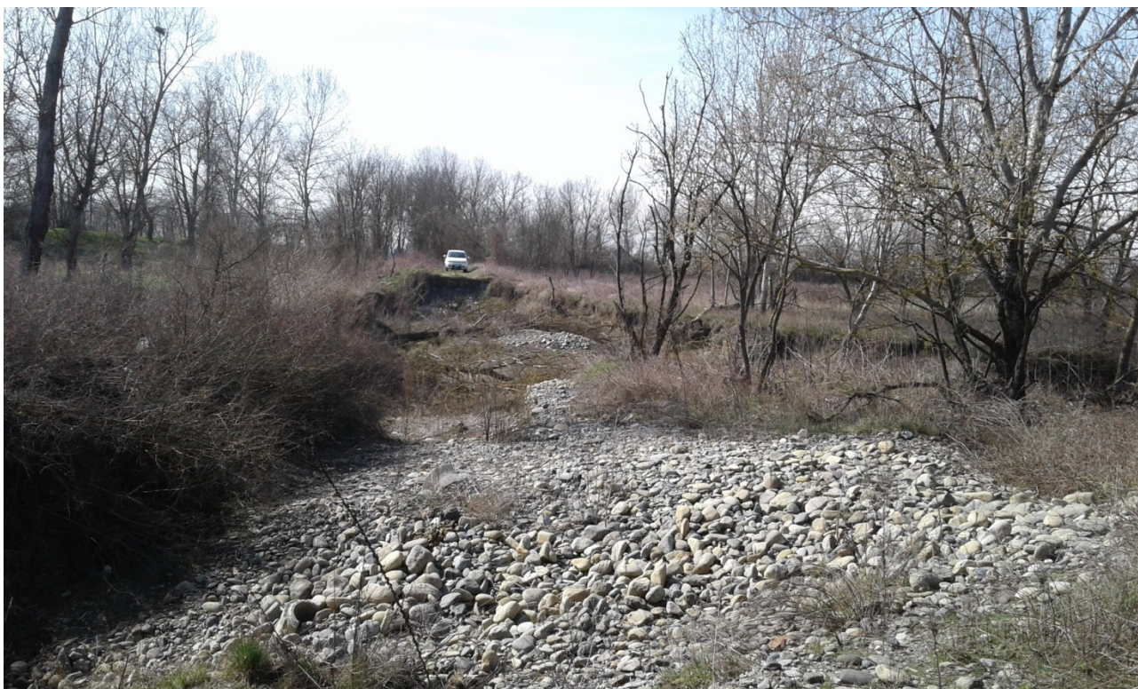
Figura 11: area golenale in cui verrà ripristinata una vecchia carraia, attualmente franata a causa di un recente evento di piena, che verrà utilizzata come pista di cantiere.
