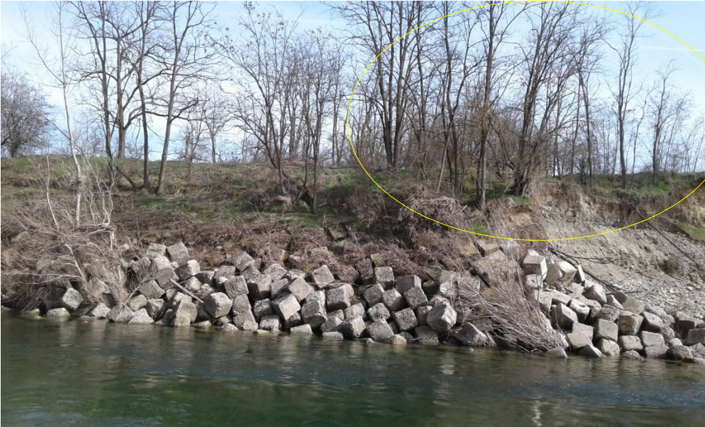
Figura 10: formazione boscata a prevalenza di robinia sulla sommità della scarpata della lunata di erosione che verrà rimossa in occasione della realizzazione della difesa di sponda.
