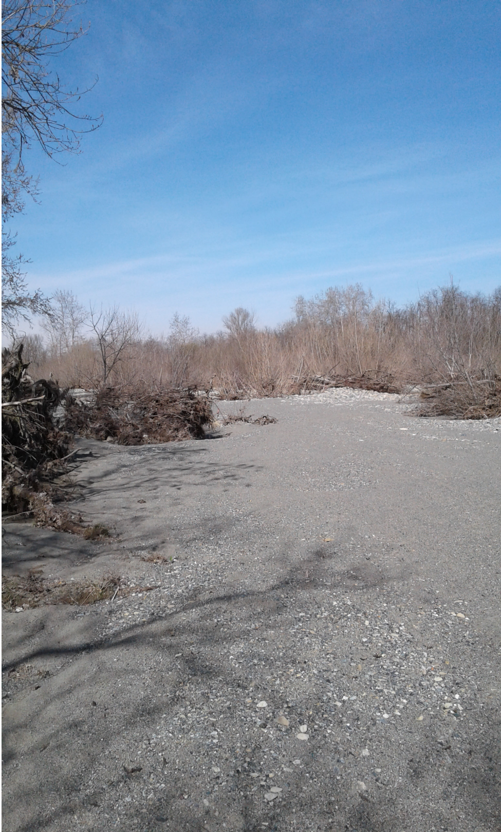
Figura 13: area di greto interessata dal passaggio della pista di cantiere
