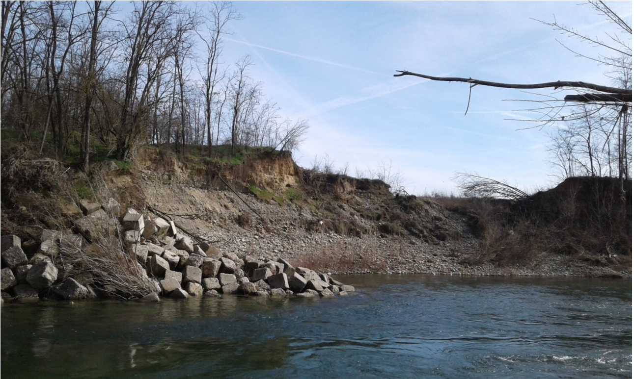
Figura 9: lunata di erosione dove è prevista la ricostruzione della linea di sponda. Si noti la zona di acque lentiche che colmano la depressione formata a seguito del crollo della difesa, che verrà colmata con materiale litoide prelevato in greto.
