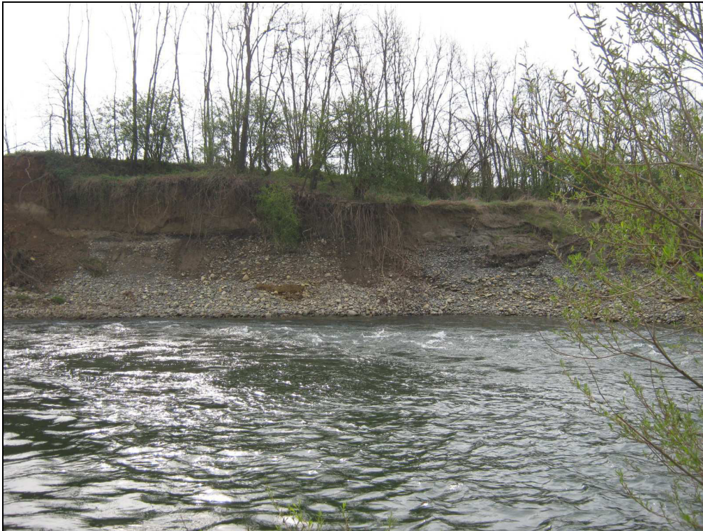
Torrente Orba: vista dalla sponda sinistra della lunata di erosione
