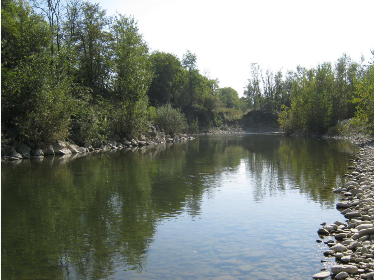
Figura 5 – Stato di fatto: erosione lungo la sponda destra del Torrente Orba vista frontale da valle
