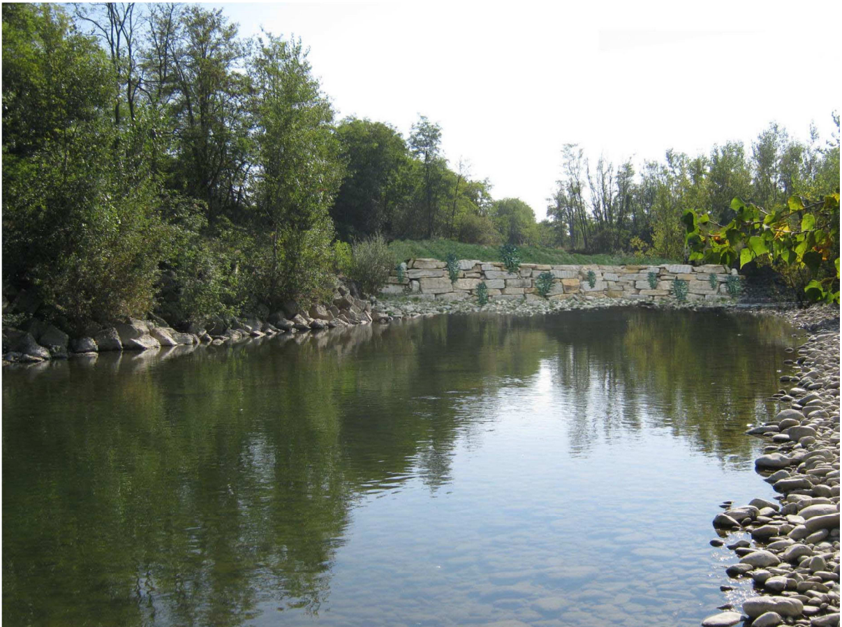
Figura 6 – Stato di progetto: realizzazione di difesa spondale in massi di cava sciolti con talee di salice, imbottimento al piede mediante materiale litoide d'alveo e successiva riprofilatura della sommità spondale con inerbimento e rivegetazione
