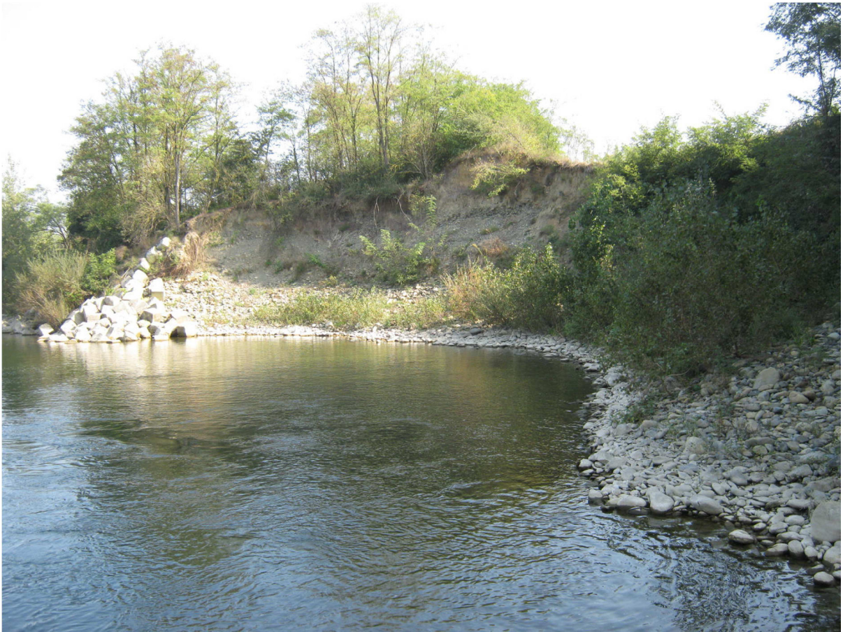
Figura 1 – Stato di fatto: erosione lungo la sponda destra del Torrente Orba
