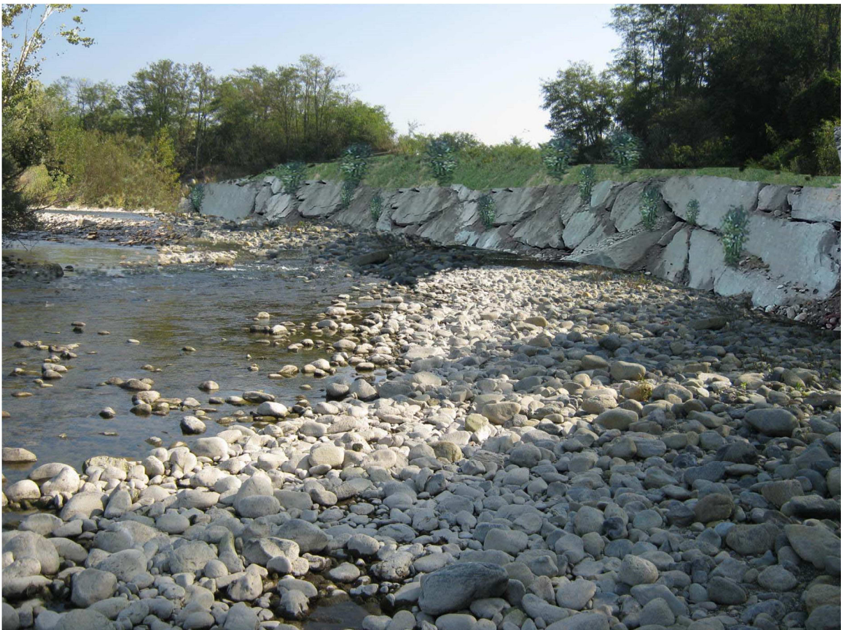
Figura 4 – Stato di progetto: realizzazione di difesa spondale in massi di cava sciolti con talee di salice, imbottimento al piede mediante materiale litoide d'alveo e successiva riprofilatura della sommità spondale con inerbimento e rivegetazione
