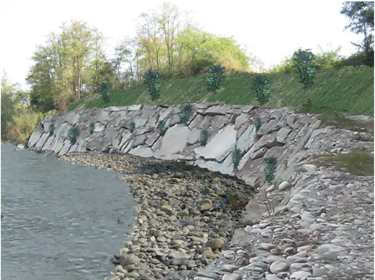
Figura 2 – Stato di progetto: realizzazione di difesa spondale in massi di cava sciolti con talee di salice, imbottimento al piede mediante materiale litoide d'alveo e successiva riprofilatura della sommità spondale con inerbimento e rivegetazione
