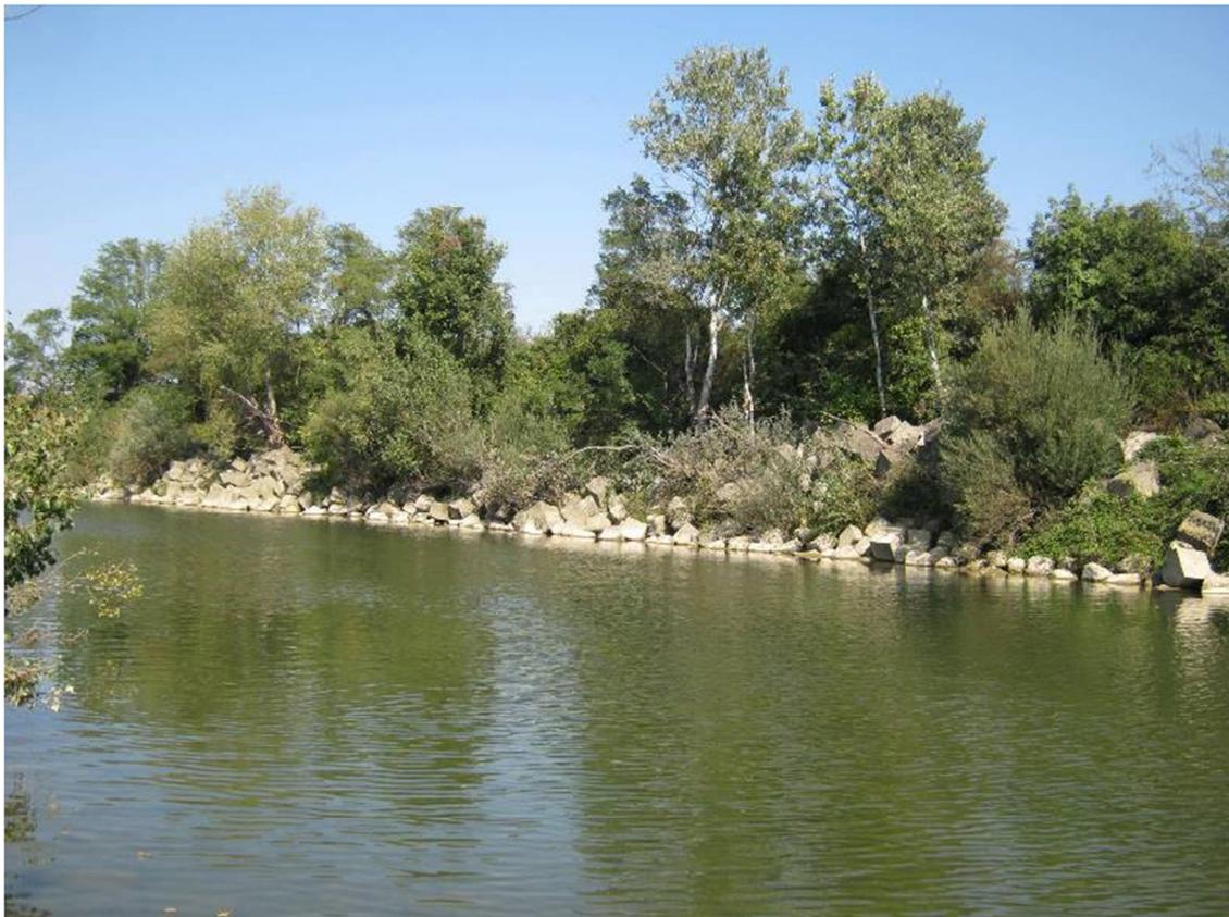
Foto 17. Torrente Orba. Vista dall'alveo della mantellata in prismi di cls a protezione della sponda dx zona di valle
