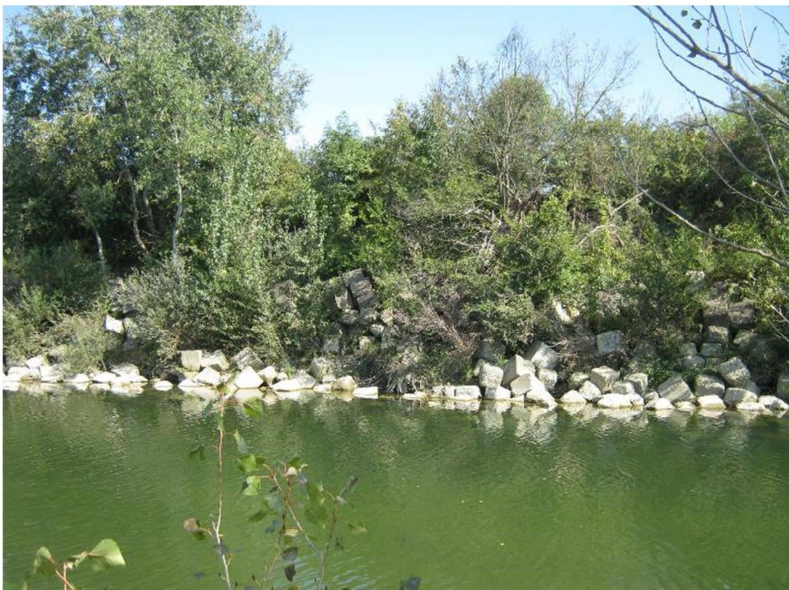
Foto 18. Torrente Orba. Vista dall'alveo della mantellata in prismi di cls a protezione della sponda dx zona di valle
