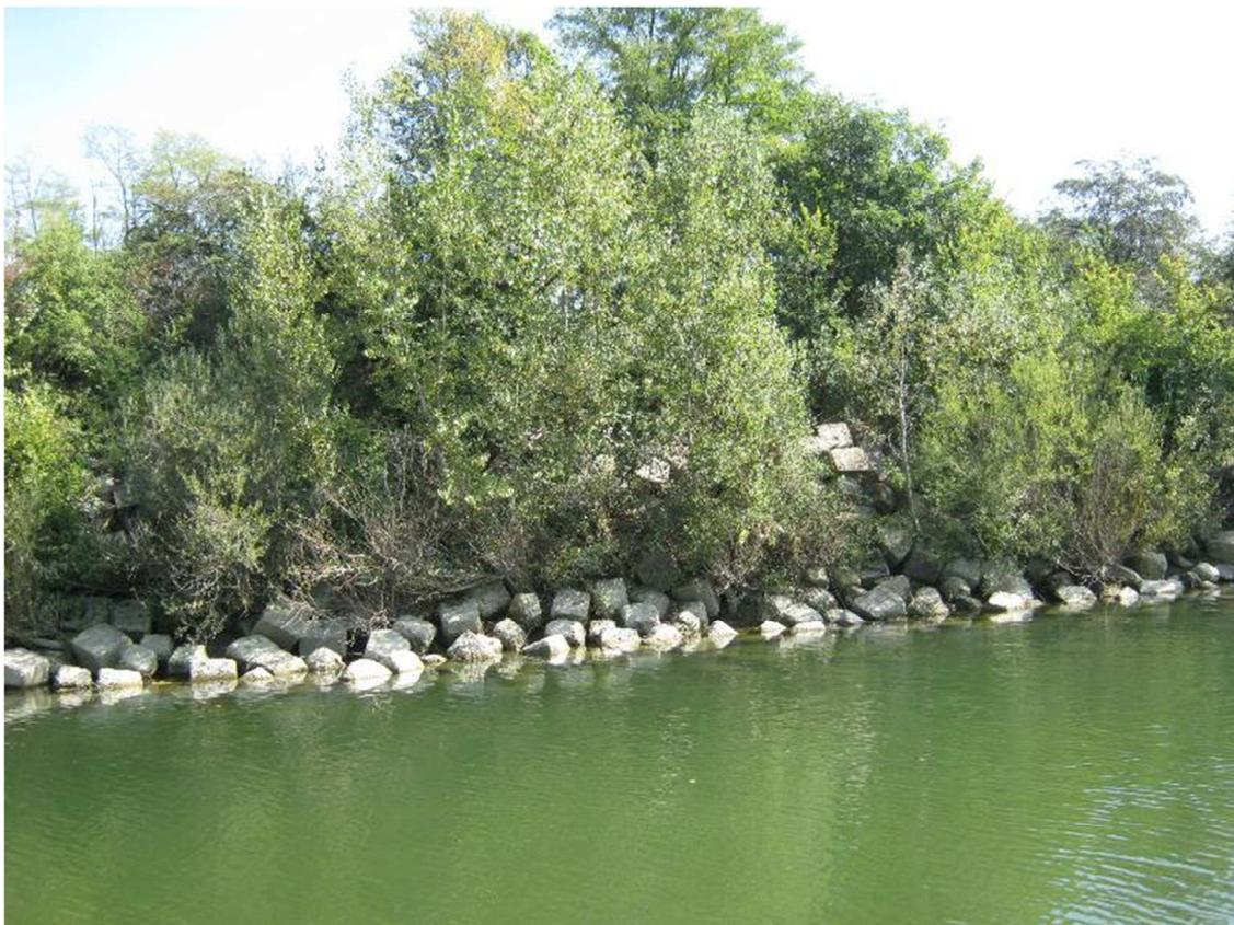
Foto 19. Torrente Orba. Vista dall'alveo della mantellata in prismi di cls a protezione della sponda dx zona di valle
