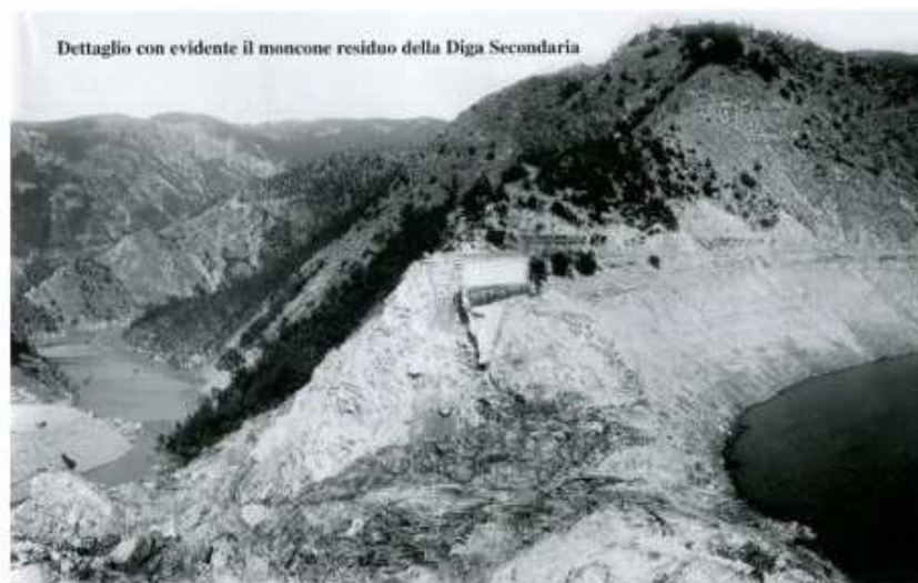
Sella Zerbino dopo il 13 agosto 1935; a sinistra il tracciato del T. Orba prima del disastro, a destra ciò che rimane del lago artificiale.
