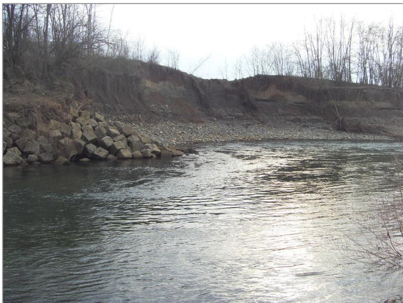
**Fig. 4** T. Orba, loc. Cascina S. Michele, sponda destra: fenomeni erosivi hanno asportato la difesa e favorito l'arretramento della linea di sponda coinvolgendo l'argine retrostante (*area di intervento*)
