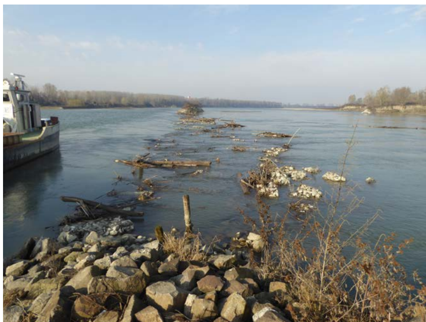
Fig. 2 - Vista dalla zona di attacco alla sponda del pennello
