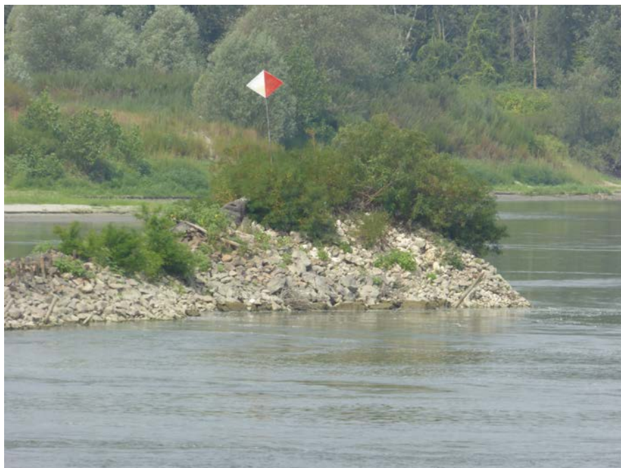
Fig. 3 – Punta del pennello (rimaneggiamento del pietrame a quota 15,50 s.l.m.)
