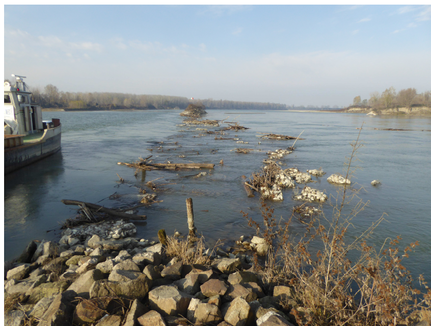
Fig. 4 - Vista dalla zona di attacco alla sponda del pennello
