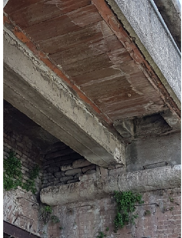
Solaio di supporto tubazione TEA S.p.a.
