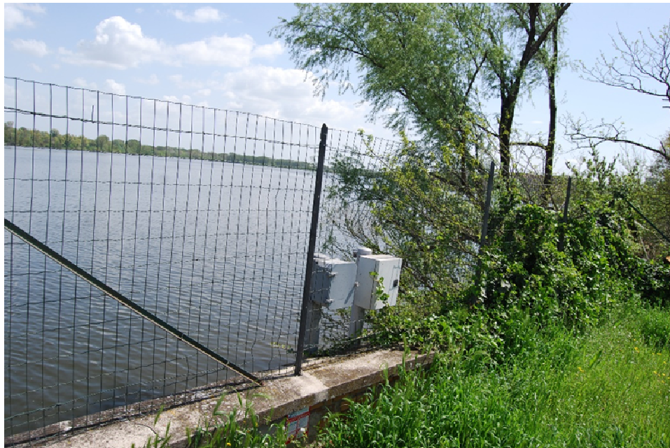
Recinzione in rete metallica plastificata e box idrometro
