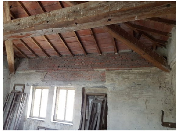
Tamponamento delle aperture originarie
