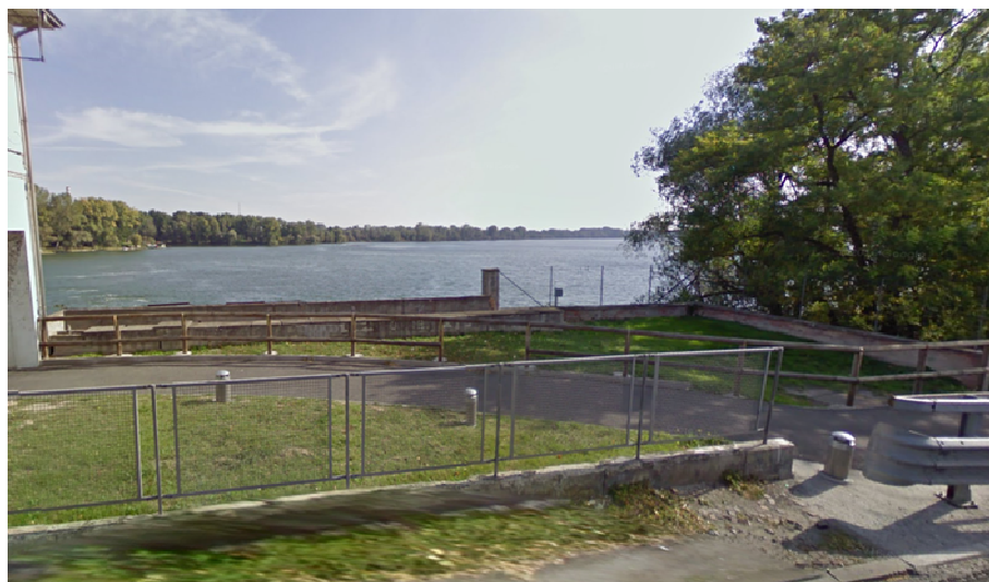
Parapetto in legno di delimitazione dell'area verde (Google Street View 2010)
