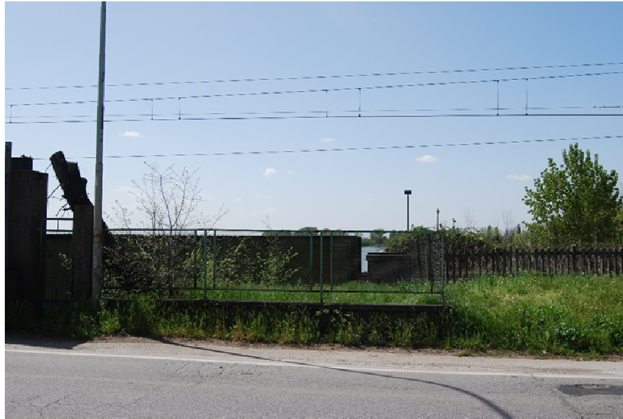
Recinzione in calcestruzzo e acciaio in Sx idraulica
