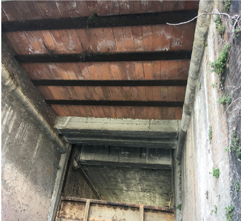
Solaio di copertura in acciaio e laterizio del canale di scarico principale
