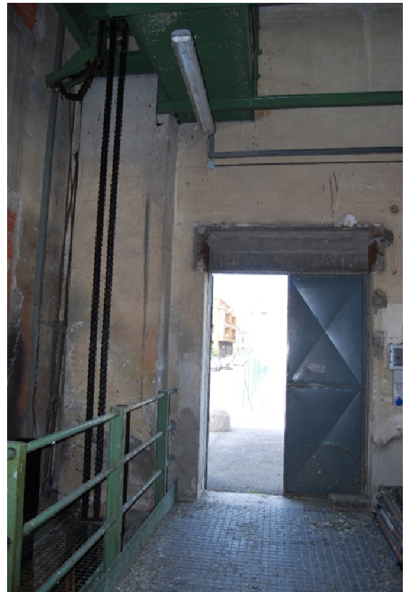
Portone d'accesso sulla parete Nord
