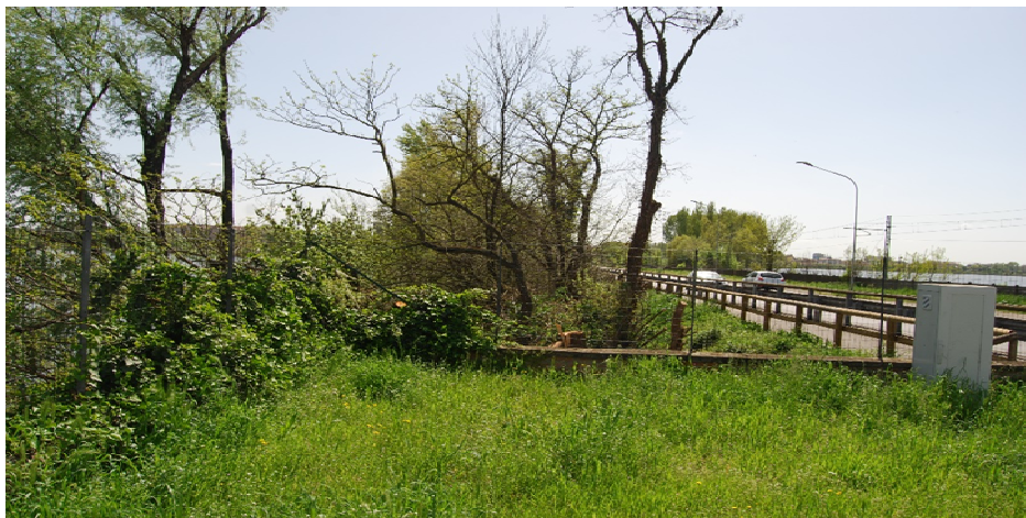
Recinzione in rete metallica plastificata e quadro acquedotto
