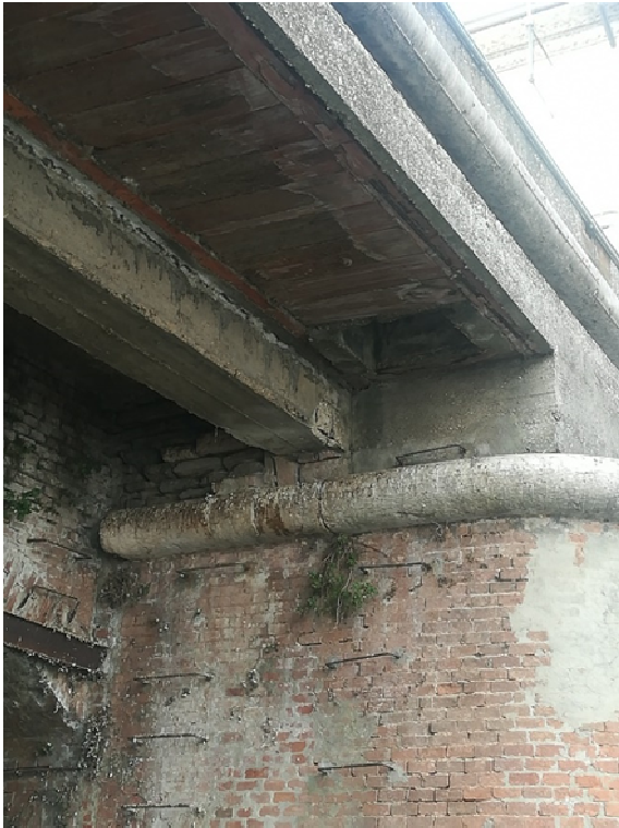
Solaio di supporto tubazione TEA S.p.a.
