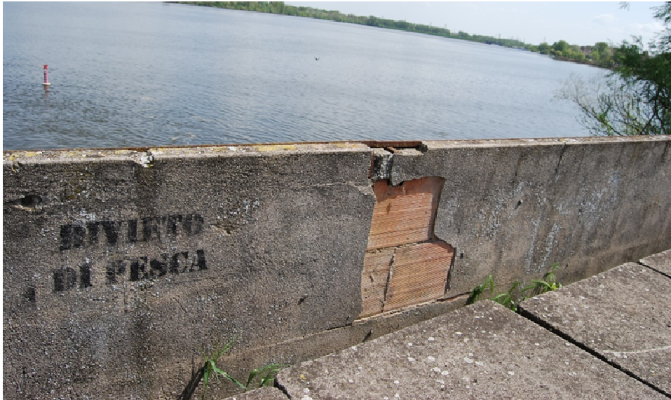
Parapetto in corrispondenza del cunicolo TEA S.p.a.
