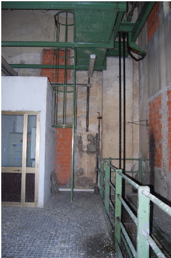
Tamponamento delle aperture originarie
