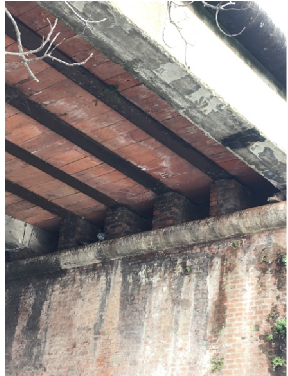
Solaio in acciaio e laterizio del canale di scarico principale
