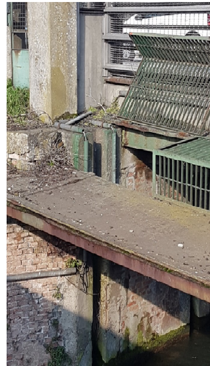
Passerella di attraversamento del canale principale
