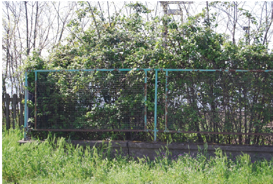
Recinzione in calcestruzzo e acciaio in Dx idraulica
