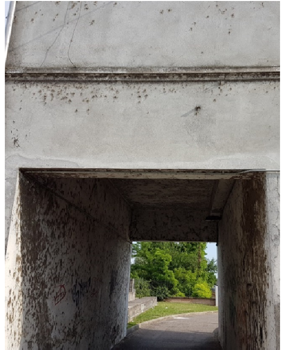
Particolare del passaggio della pista ciclopedonale
