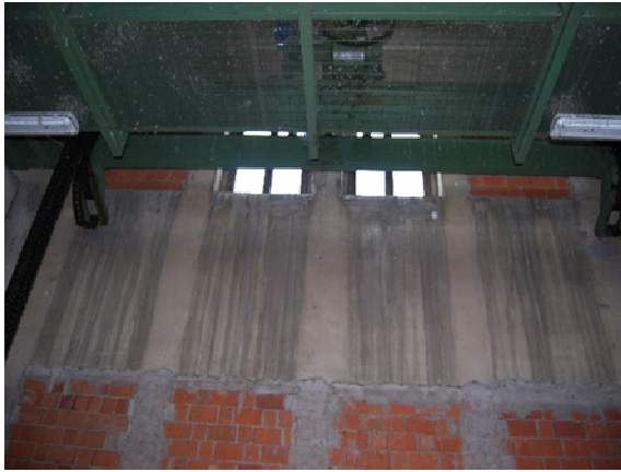
Tamponamento delle aperture originarie
