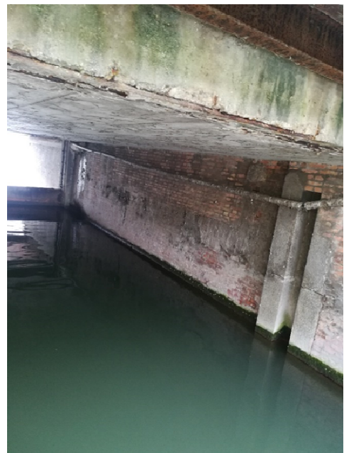
Solaio di copertura in c.a. del canale di scarico principale
