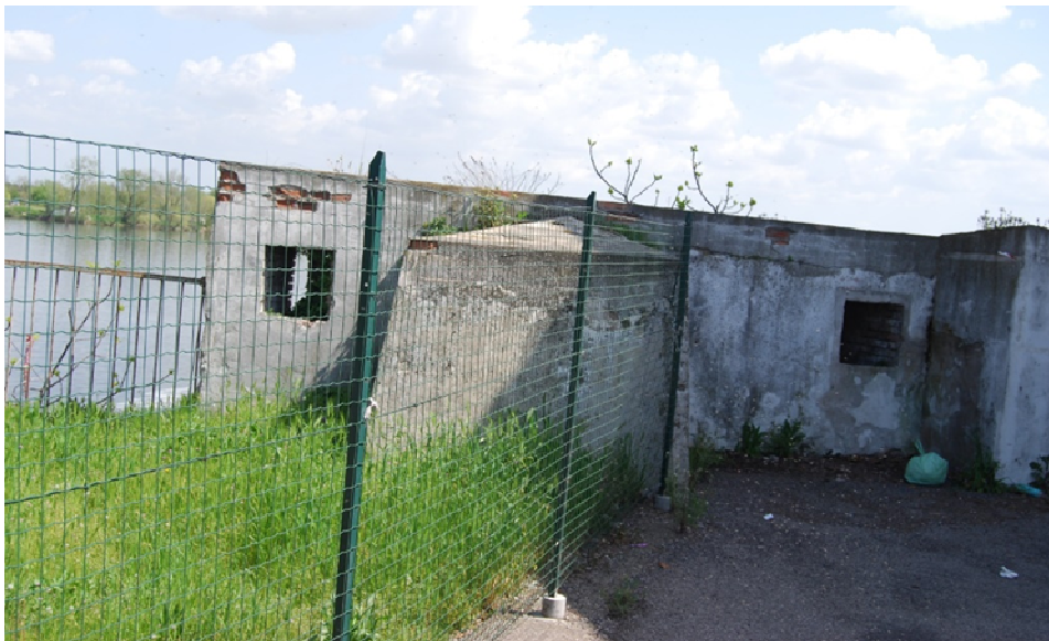
Muratura originaria in mattoni pieni sul lato Nord
