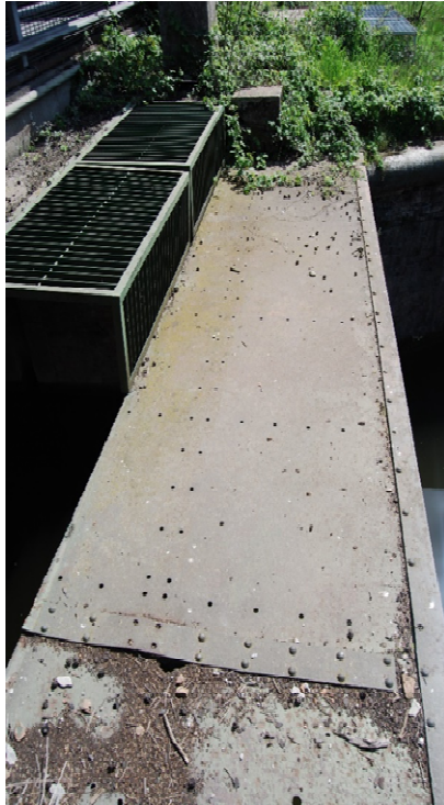
Passerella di attraversamento del canale principale
