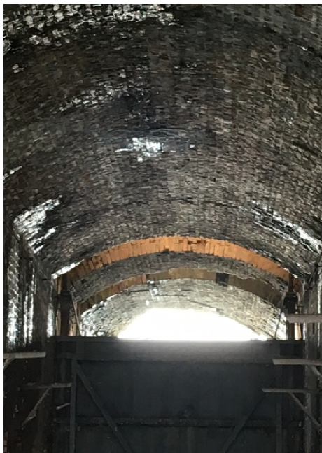
Volta di copertura in mattoni dei canali di scarico minori
