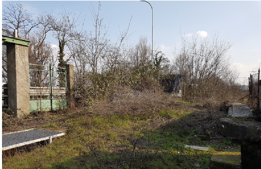
Panoramica della zona esterna di monte in Dx idraulica
