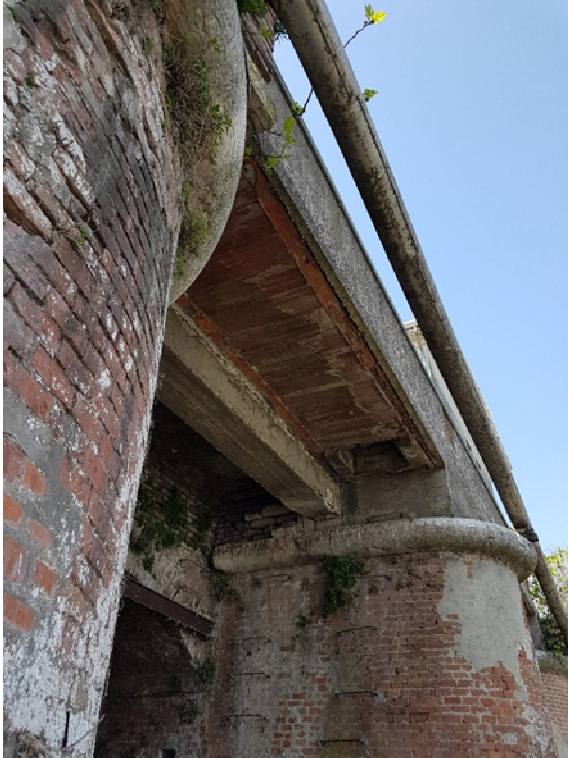
Solaio di supporto tubazione TEA S.p.a.
