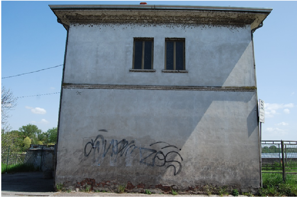
Veduta d'insieme del locale di alloggiamento della paratoia principale da ex S.S. 62
