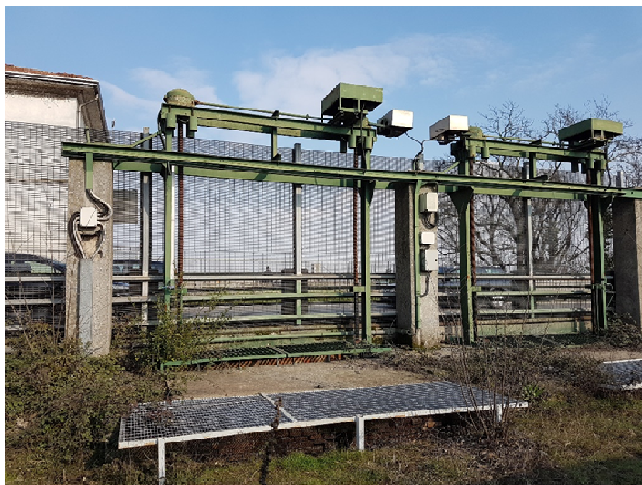
Protezione delle feritoie di scorrimento dei panconi dei canali minori
