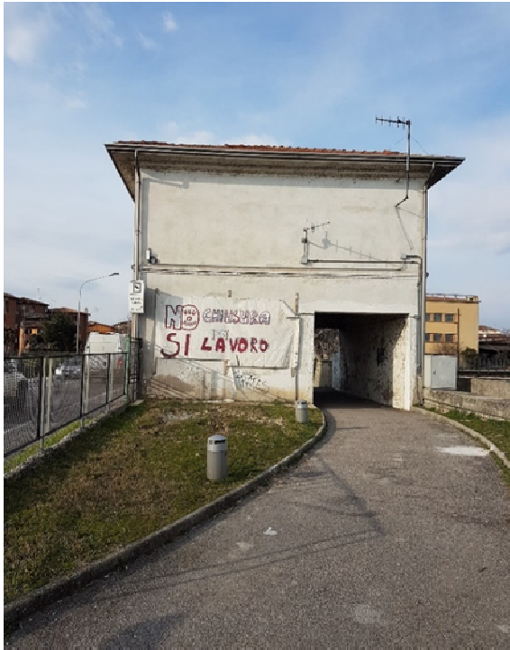
Veduta d'insieme del locale di alloggiamento della paratoia principale da pista ciclopedonale
