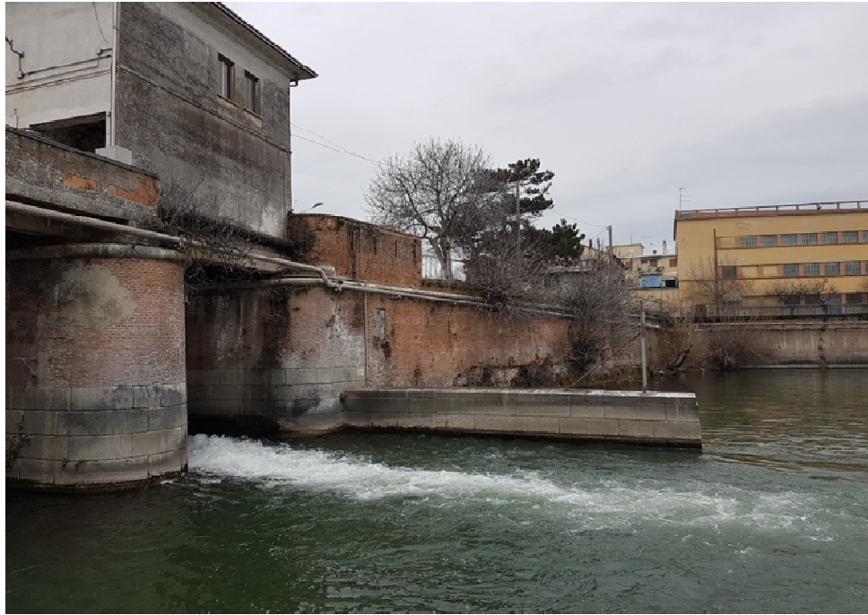
Canale di scarico principale e dissipatore in Sx idraulica visti dal Lago di Mezzo
