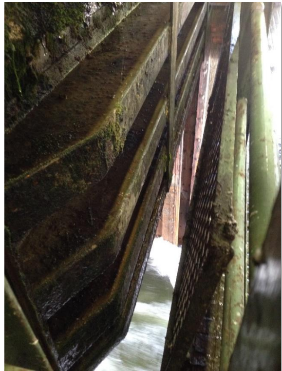
Struttura della paratoia principale
