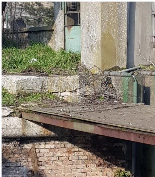
Pilastro esistente in sponda sinistra del pancone PM3
