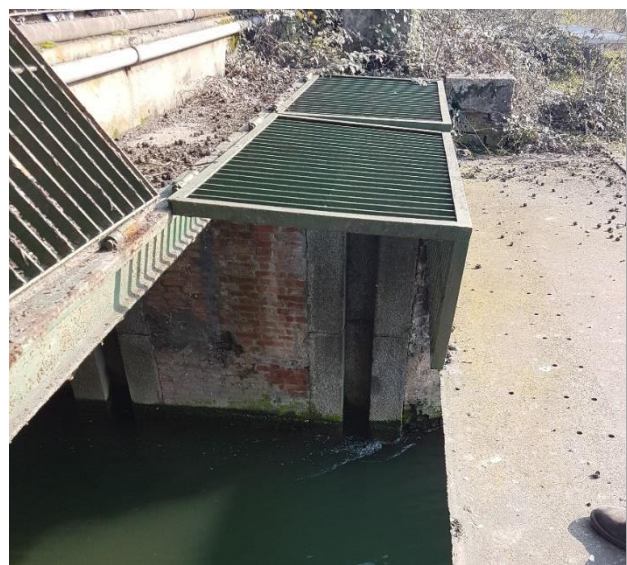
Pilastro esistente in sponda destra del pancone PM3
