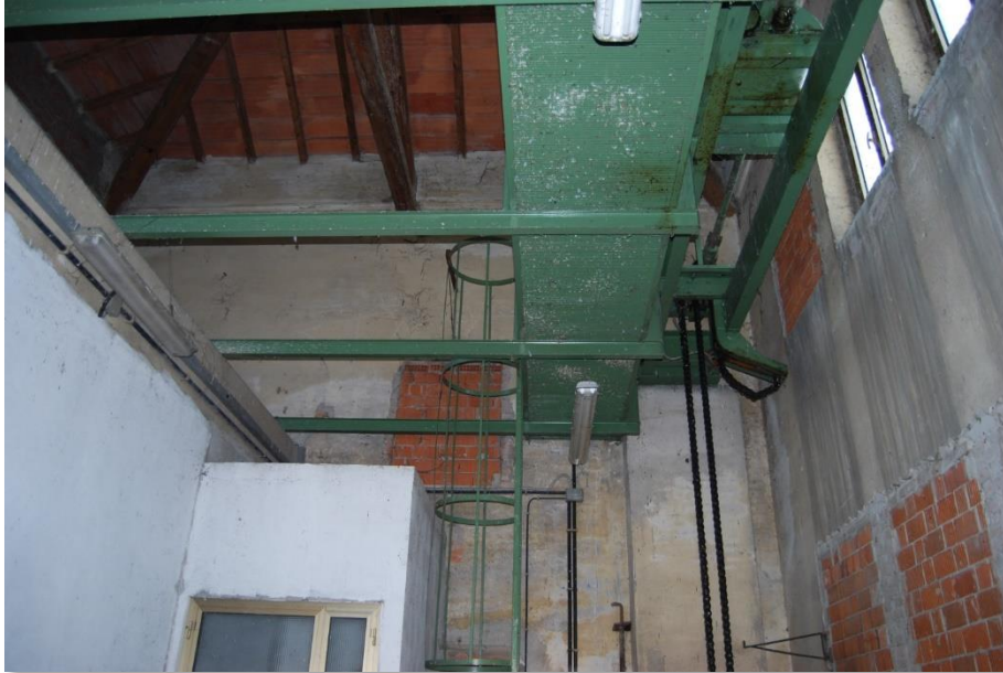
Vista interna dell'edificio di alloggiamento della paratoia principale e del relativo meccanismo di movimentazione
