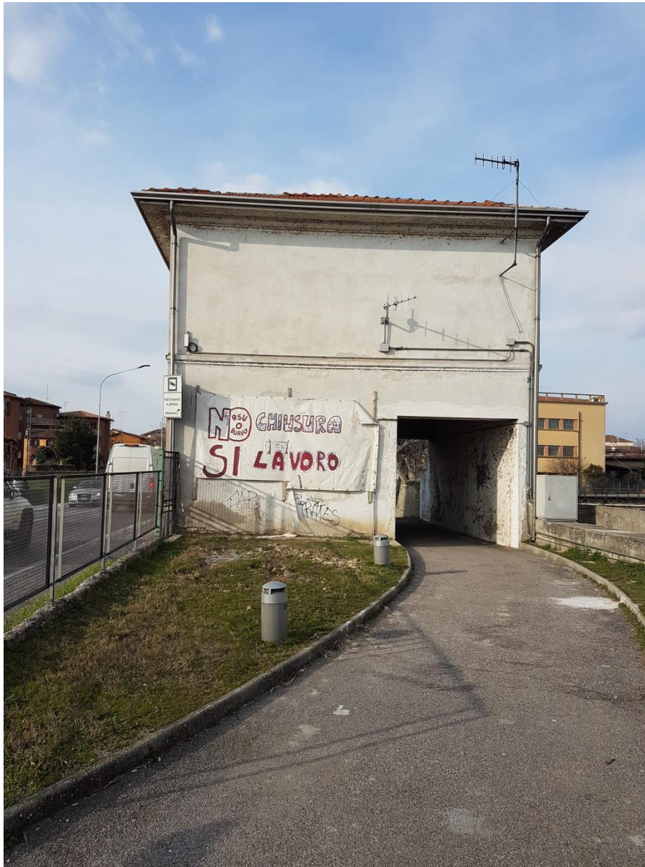
L'edificio di alloggiamento della paratoia principale attraversato dalla pista ciclopedonale
