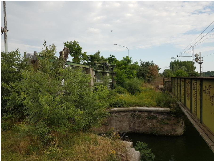
Vista di monte verso Sud tra il manufatto e la ferrovia
