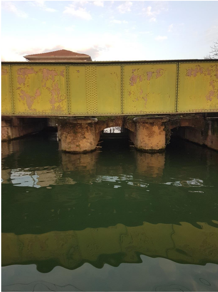
Vista di monte dei canali di scarico dalla pista ciclopedonale Mantova - Peschiera
