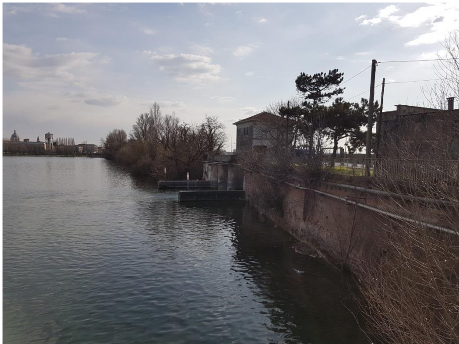
Viste del Vasarone dal lato di valle dalla pista ciclabile
