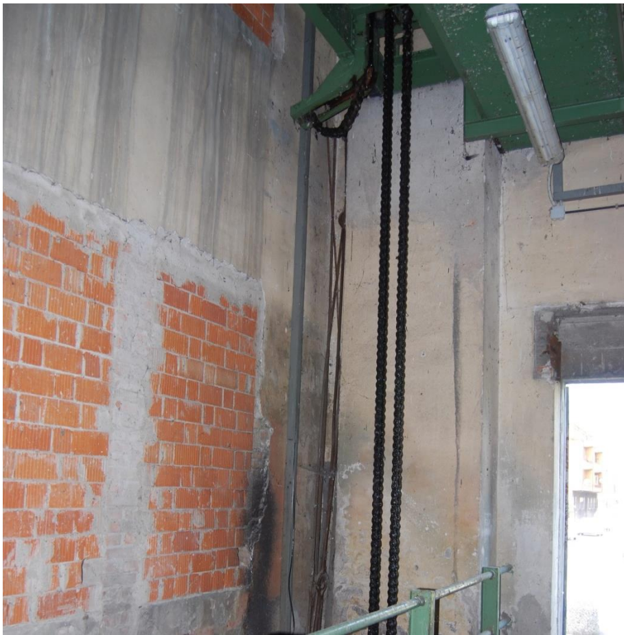
Vista interna dell'edificio di alloggiamento della paratoia principale e del relativo meccanismo di movimentazione
