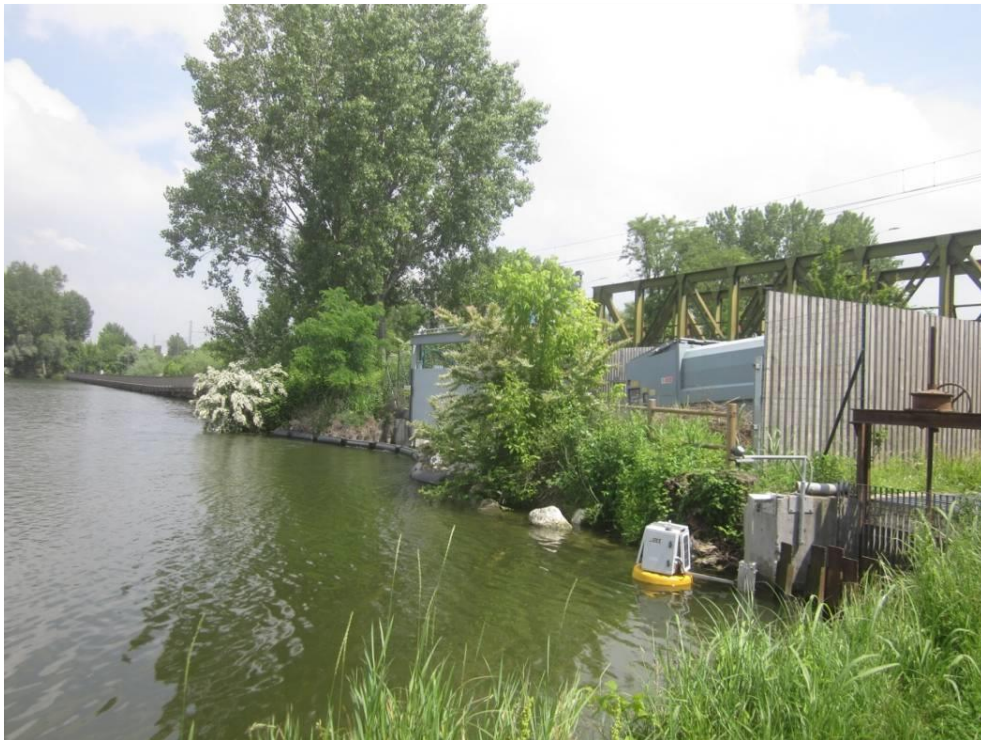
Figura 20 - Centrale idroelettrica detta Vasarina.
