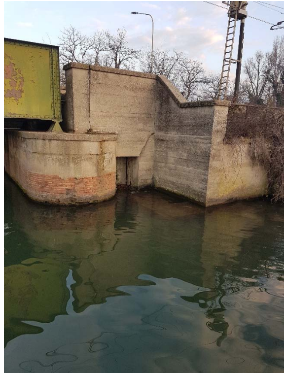
Figura 9 Monte spalla Mantova
