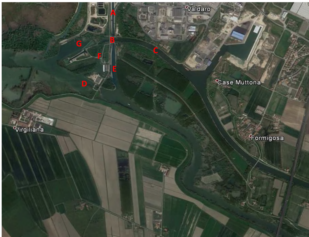
Figura 4-6 - Nodo idraulico di Formigosa – A =Diversivo; B = sifone; C = canale navigabile Fisero – Canal Bianco; D = Fornice e controfornice; E = idrovore; F= scaricatore Vallazza-Fisero; G = conca di Valdaro
