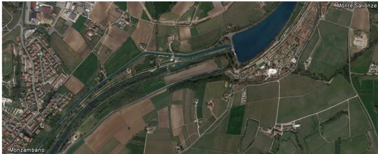
Figura 4-3 - Sbarramento di Salionze
