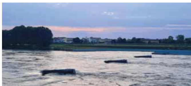
Po a Casale M.to – traversa idroelettrica Idrobavento
