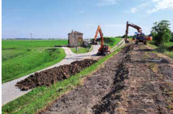
Figura 1 – Risagomatura dell'argine di II linea di difesa dal mare Boccasette-Cà Zuliani (Porto Tolle)
