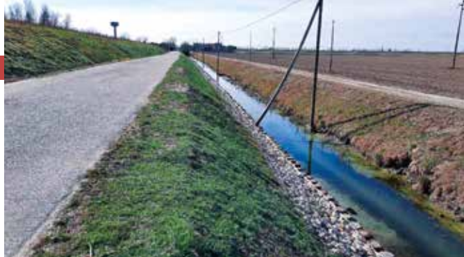
Intervento di realizzazione della palificata realizzato anno 2021 tra stanti 24-26 (RO-E-454)
