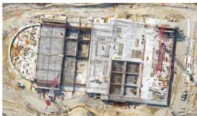
Figura 4 - Ortofoto rappresentativa dell'avanzamento dei lavori sul Manufatto C alla data del 21 marzo
