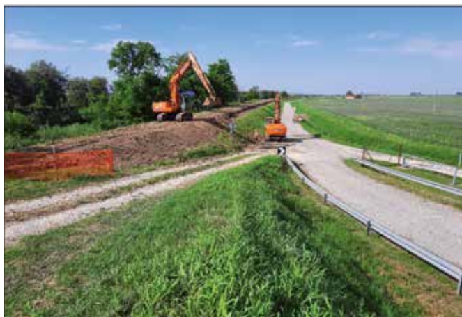
Figura 2 – Risagomatura dell'argine di II linea di difesa dal mare Boccasette-Cà Zuliani (Porto Tolle)
