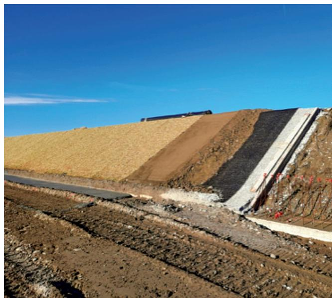
Particolare della sovrapposizione delle varie fasi di protezione sul rilevato paramento lato fiume (si notano il tagliano alla base della mantellata in c.a., la mantellata in c.a., il giunto waterstop in PVC, la geogriglia, lo strato di terreno tra la geogriglia e la biostuaia in fibre naturali e cocco)
