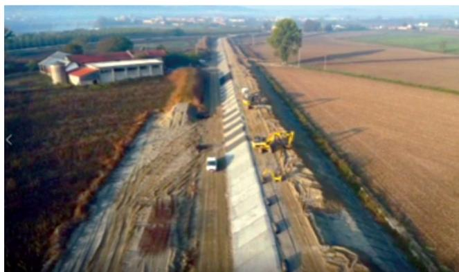
Vista dal drone delle Fasi di realizzazione della mantellata in c.a. armata con rete elettrosaldata e giunti di dilatazione waterstop in PVC lato fiume (foto2)
