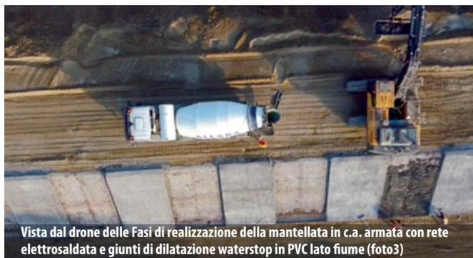
Vista dal drone delle Fasi di realizzazione della mantellata in c.a. armata con rete elettrosaldata e giunti di dilatazione waterstop in PVC lato fiume (foto3)
