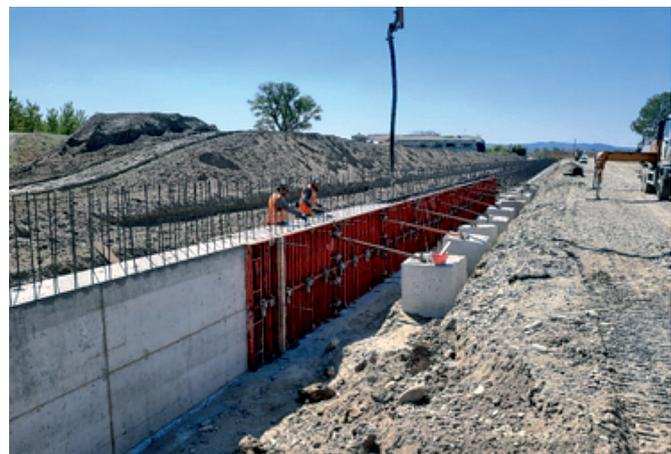
Fasi di realizzazione del tagliare alla base della mantellata in c.a. lato fiume del realizzando rilevato arginale (foto2)
