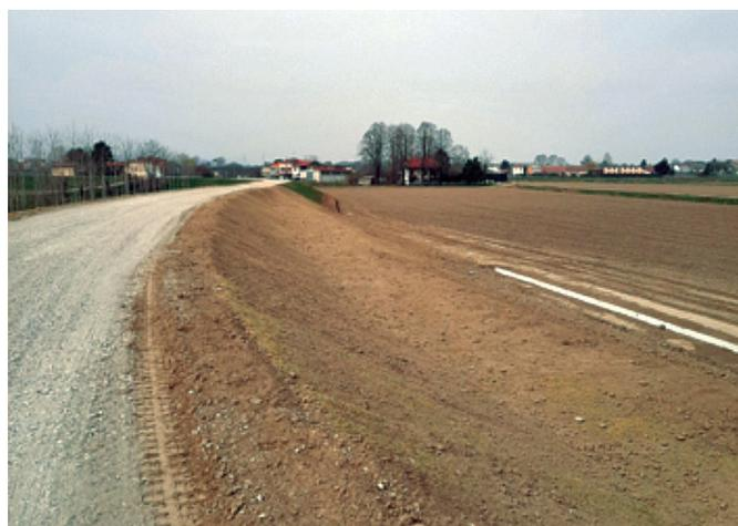
Vista della pista sulla sommità arginale in misto stabilizzato con trattamento di fresatura a freddo dello strato più superficiale e del paramento lato campagna in attesa della fase successiva di inerbimento con idrosemina
