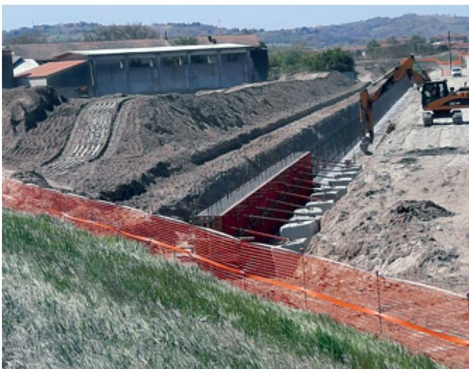
Fasi di realizzazione del tagliare alla base della mantellata in c.a. lato fiume del realizzando rilevato arginale (foto1)
