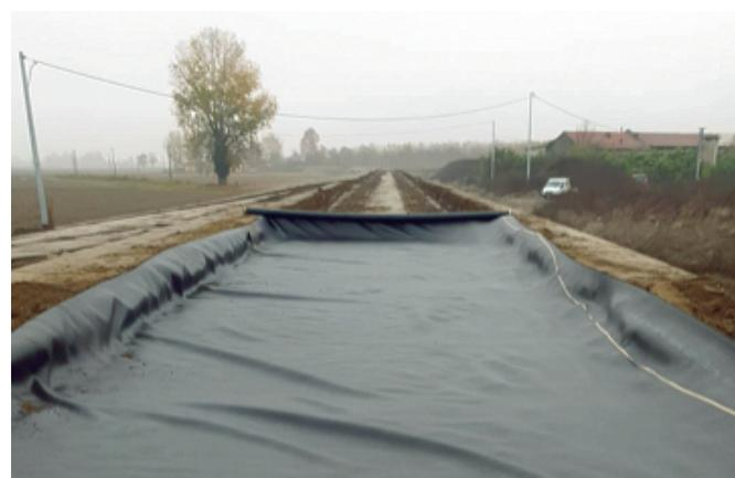
Particolare della stesa del geotessuto prima della realizzazione della pista sulla sommità arginale in misto stabilizzato con trattamento di fresatura a freddo dello strato più superficiale
