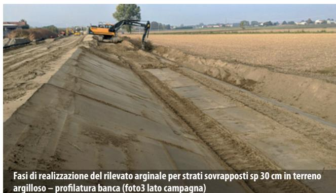
Fasi di realizzazione del rilevato arginale per strati sovrapposti sp 30 cm in terreno argilloso - profilatura banca (foto3 lato campagna)
