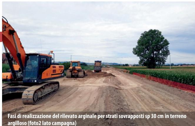
Fasi di realizzazione del rilevato arginale per strati sovrapposti sp 30 cm in terreno argilloso (foto2 lato campagna)
