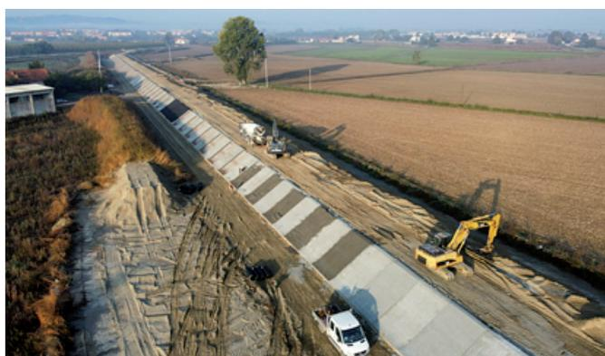
Vista dal drone delle Fasi di realizzazione della mantellata in c.a. armata con rete elettrosaldata e giunti di dilatazione waterstop in PVC lato fiume (foto4)
