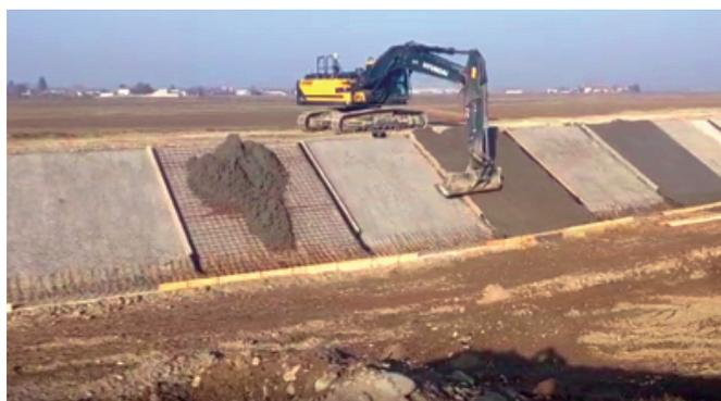
Fasi di realizzazione della mantellata in c.a. armata con rete elettrosaldata e giunti di dilatazione waterstop in PVC lato fiume (foto1)
