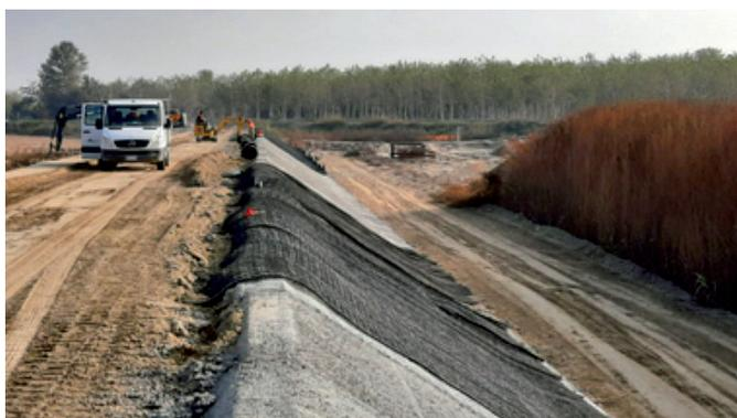
Fasi di posa della geogriglia costituita da una rete metallica a doppia torsione rinforzata con funi in acciaio sulla mantellata in c.a. lato fiume (foto 1)
