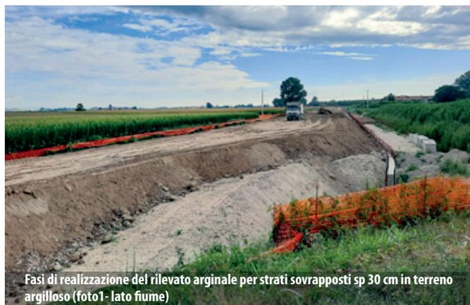
Fasi di realizzazione del rilevato arginale per strati sovrapposti sp 30 cm in terreno argilloso (foto1- lato fiume)
