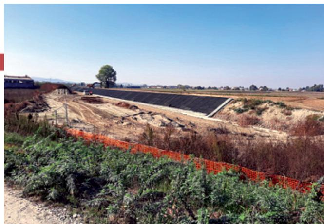
Fasi di posa della geogriglia costituita da una rete metallica a doppia torsione rinforzata con funi in acciaio sulla mantellata in c.a. lato fiume (foto 2)
