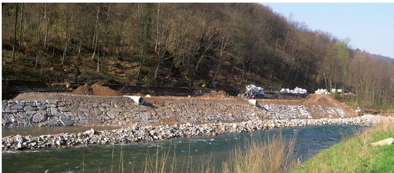
Fiume Tresa - Intervento sponda italiana, km 3.300
