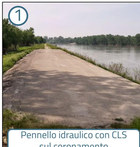
Pennello idraulico con CLS sul coronamento
