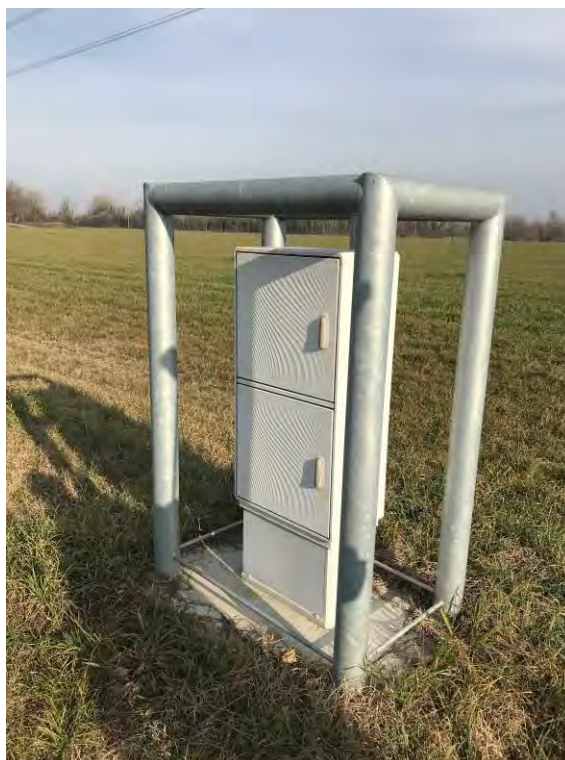
Foto 10 – quadro elettrico per alimentazione del sistema di irrigazione del vigneto presente in golena
