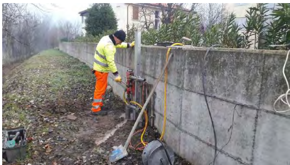
Foto 16. Esecuzione carotaggio C2
