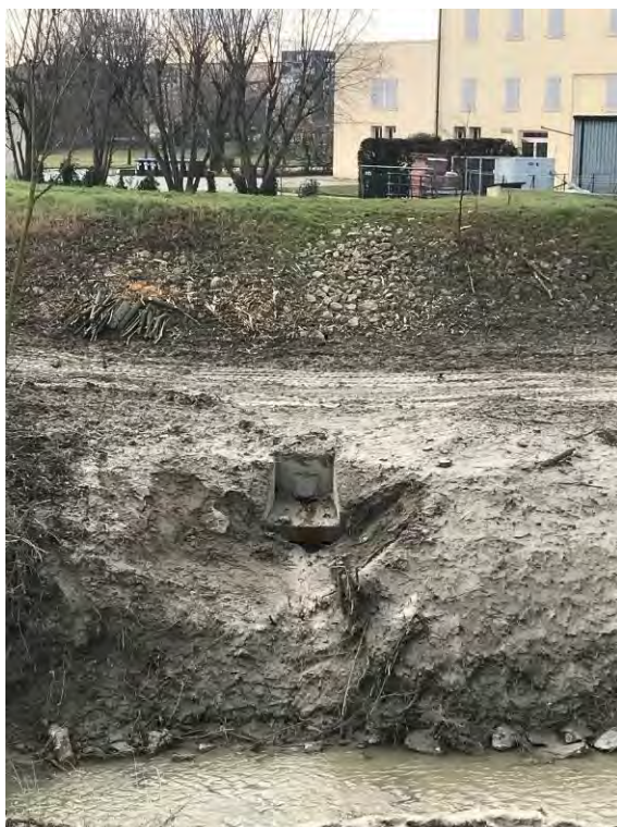
Foto 15 – punto di scarico del fosso di scolo con clapet, lato fiume
