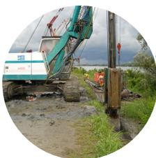
Si scava una trincea profonda lungo l'argine (anche con benne o idrofresa).
