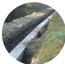
La trincea viene poi riempita con materiale impermeabile (es. miscela cemento-bentonite o calcestruzzo plastico).
