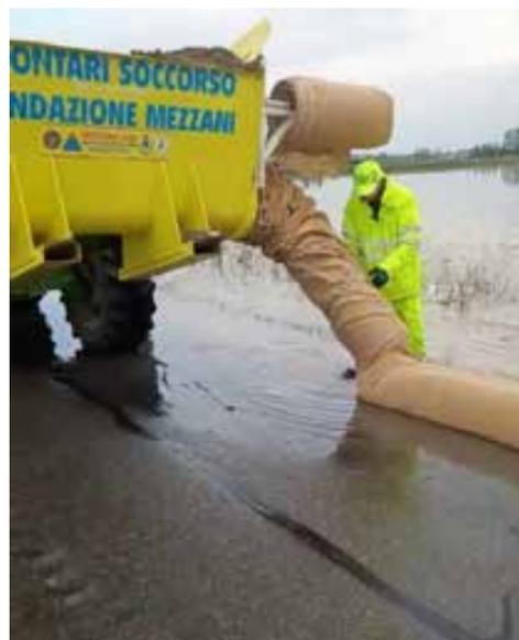
Foto 12 - Trattore con coclea riempitrice del tubo in tela di juta
