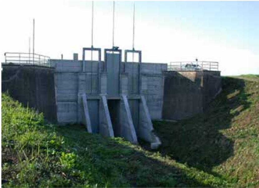
Foto 3 - Chiavica di Sanguigna (PR): batteria di paratoie (lato fiume) su argine di Po tratto medio. Verifica ed eventuale chiusura al segnale di sospetto!
