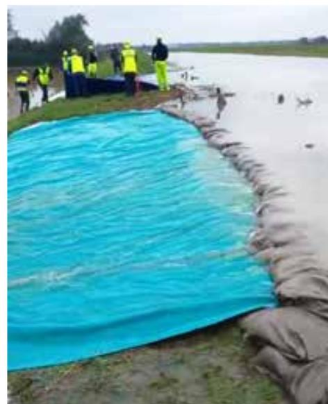
Foto 13 - Coronella e telo antierosione di scarpata - 20/10/24
