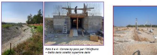
Foto 3 e 4 - Canale by-pass per l'ittiofauna - Getto della soletta superiore dello scotatore del manufatto di presa
