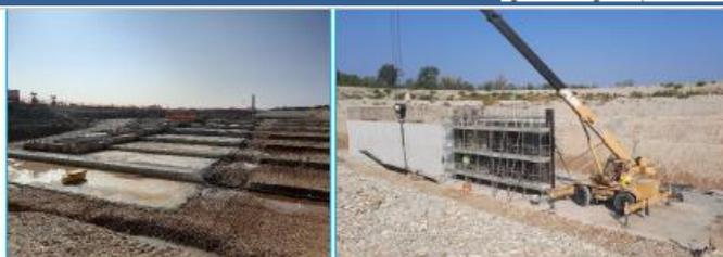
Foto 1 e 2 - Manufatto C - Getto della platea di sottofondazione e cassatura del terzo cono del taglio
