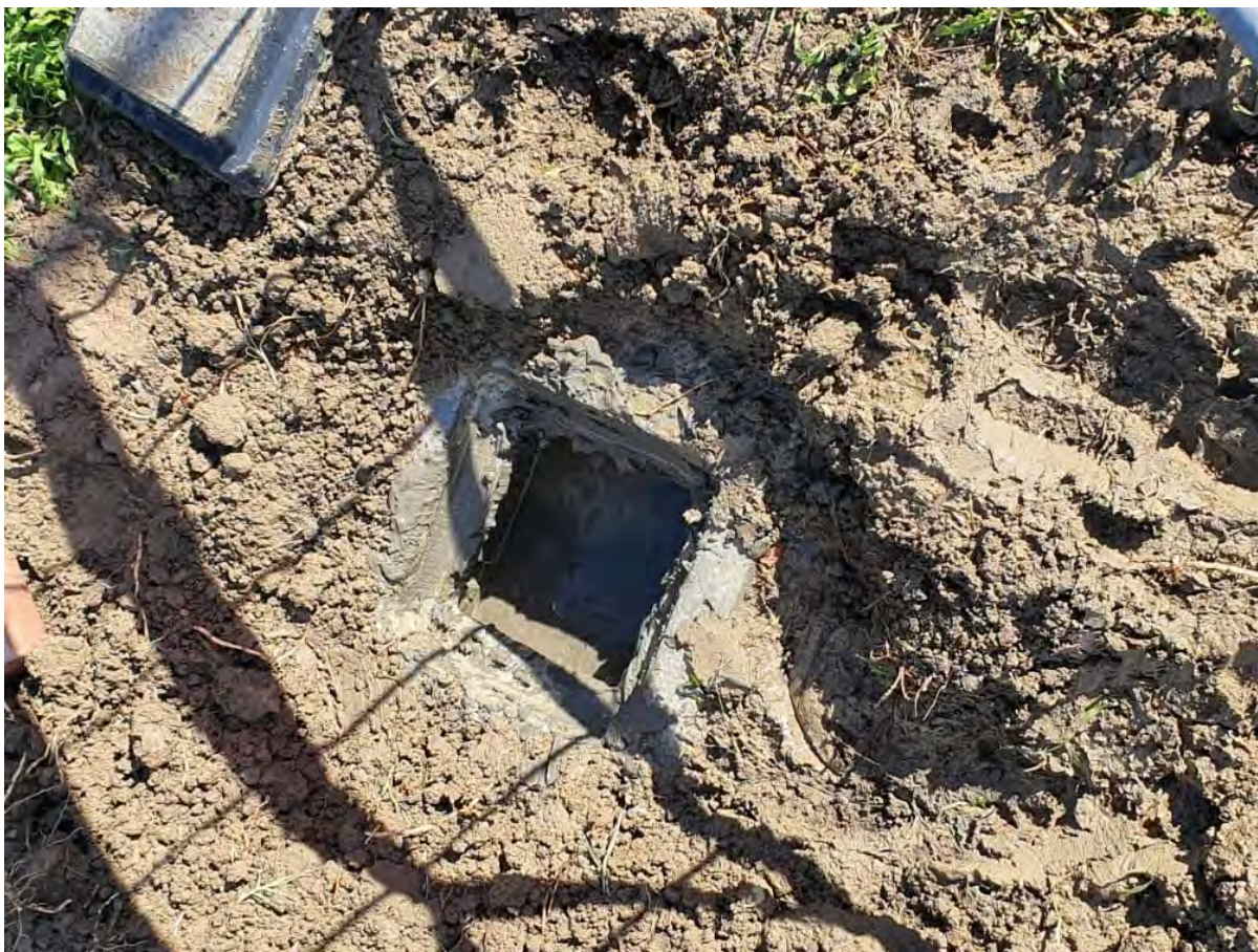
Cementazione Pz3 a 30m da Pozzo2
