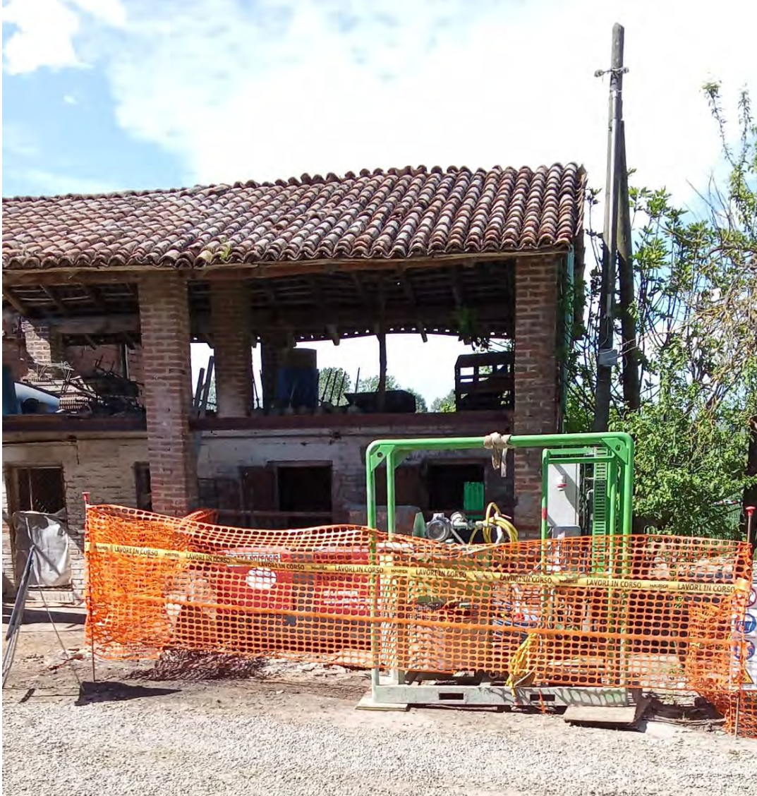
Posizionamento impianto iniezione Pozzo 1
