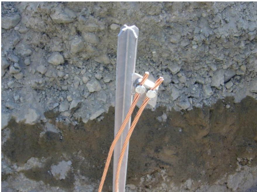
Figura 22 – Esempio di impianto di messa a terra con picchetti dispersori
