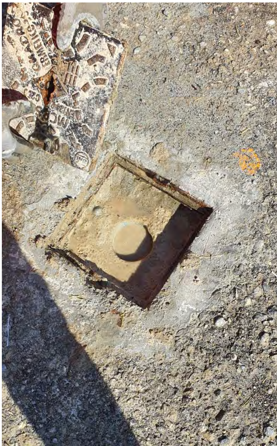
Cementazione Pz2 a 20m da Pozzo2
