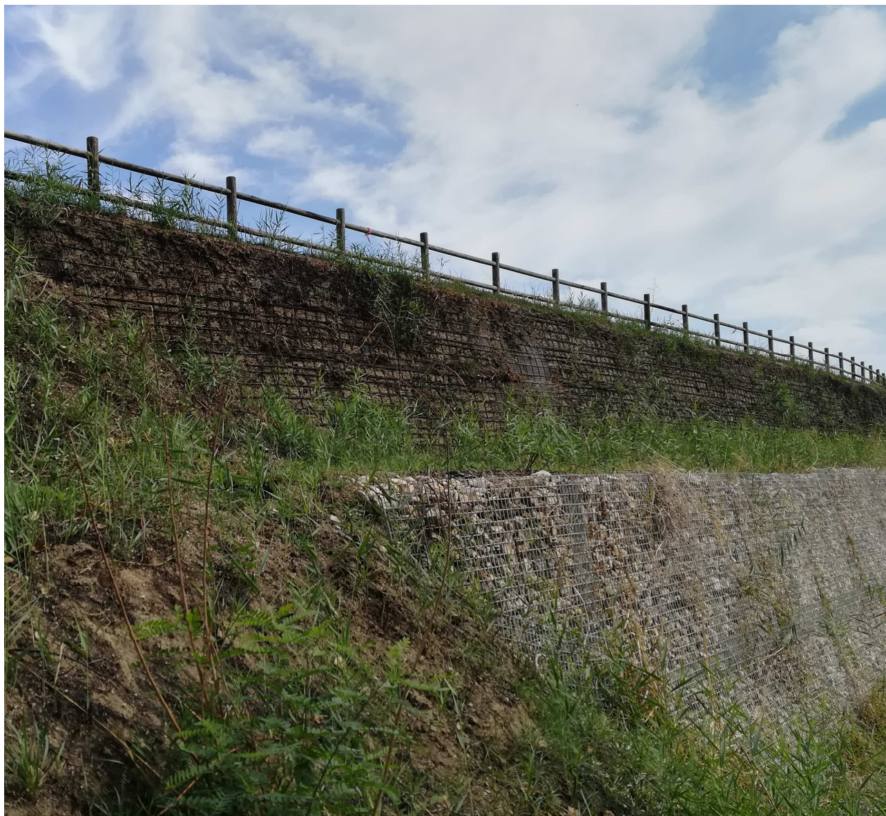
Particolare del murallex in basso e della terra armata ammalorata dall'incendio in alto
