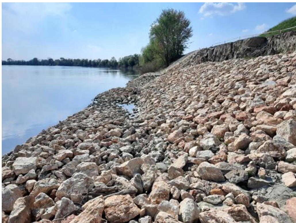
Sponda sinistra del fiume Po – Stanti 352-353 – loc.tà Guarda Veneta vista del dissesto da valle – in evidenza la scarpata spondale e la sottostante berma ribassate e dislocate verso fiume rispetto alla sagoma in posto (sullo sfondo)
