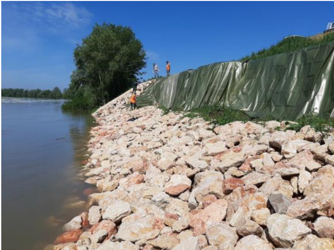
Posa in opera di telonata impermeabile a protezione della scarpata di frana – 14/05/2021 – vista dal basso
