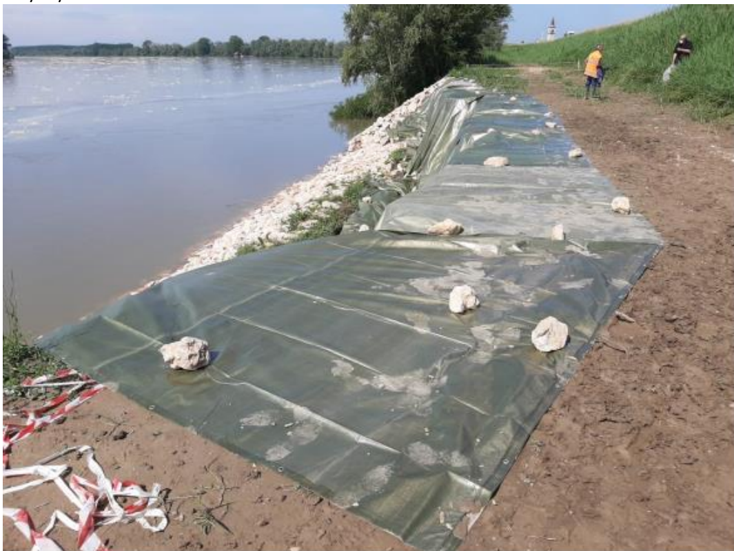
Posa in opera di telonata impermeabile a protezione della scarpata di frana – 14/05/2021 – vista dall'alto
