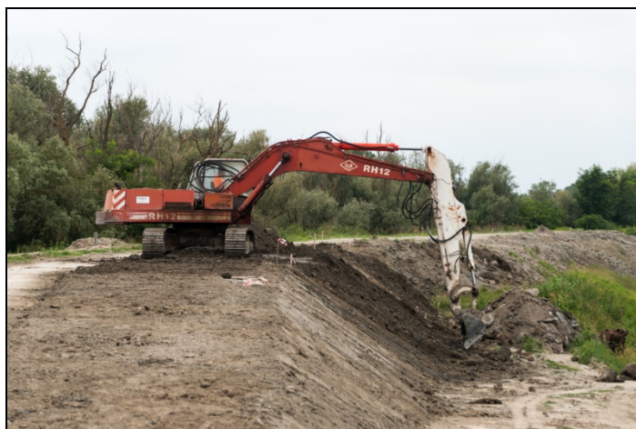
Immagine rappresentativa dell'attività di formazione del rilevato arginale
