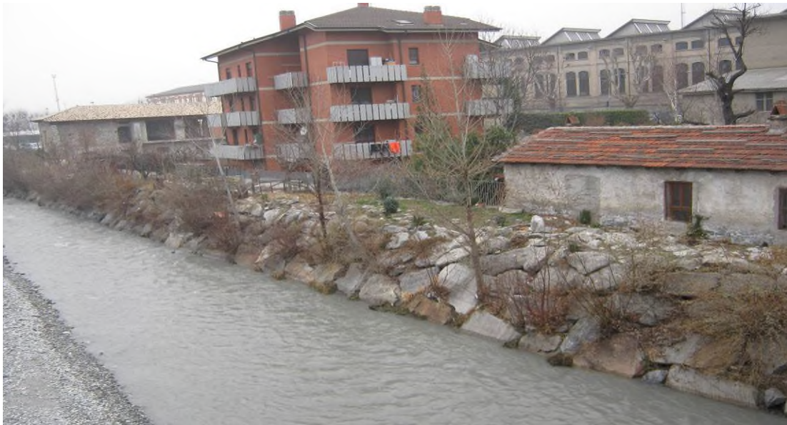
Fig. 3 - Tratto a monte del ponte di Ferro, in cui la sponda è attualmente protetta da una scogliera in massi.
