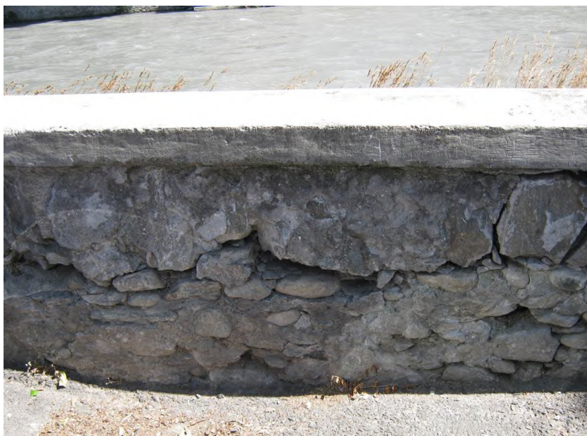
Fig. 27 - Muro in pietra delimitante la sponda destra nel secondo tratto a valle del Ponte Vecchio, le cui caratteristiche architettoniche verranno riprodotte nel muro in progetto lungo il paramento di monte.
