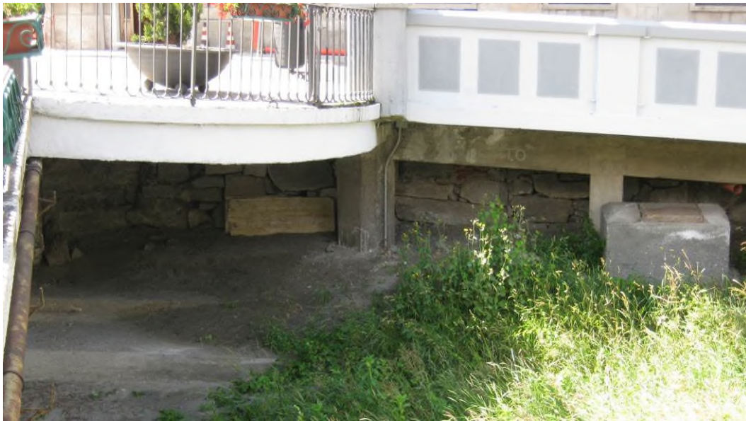
Fig. 31 - Particolare del muro in pietra originario, arretrato rispetto al parapetto di recente costruzione.
