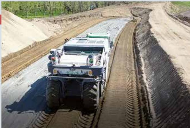
Ricostruzione dell'argine di Motta de' Conti con stabilizzazione a cemento
