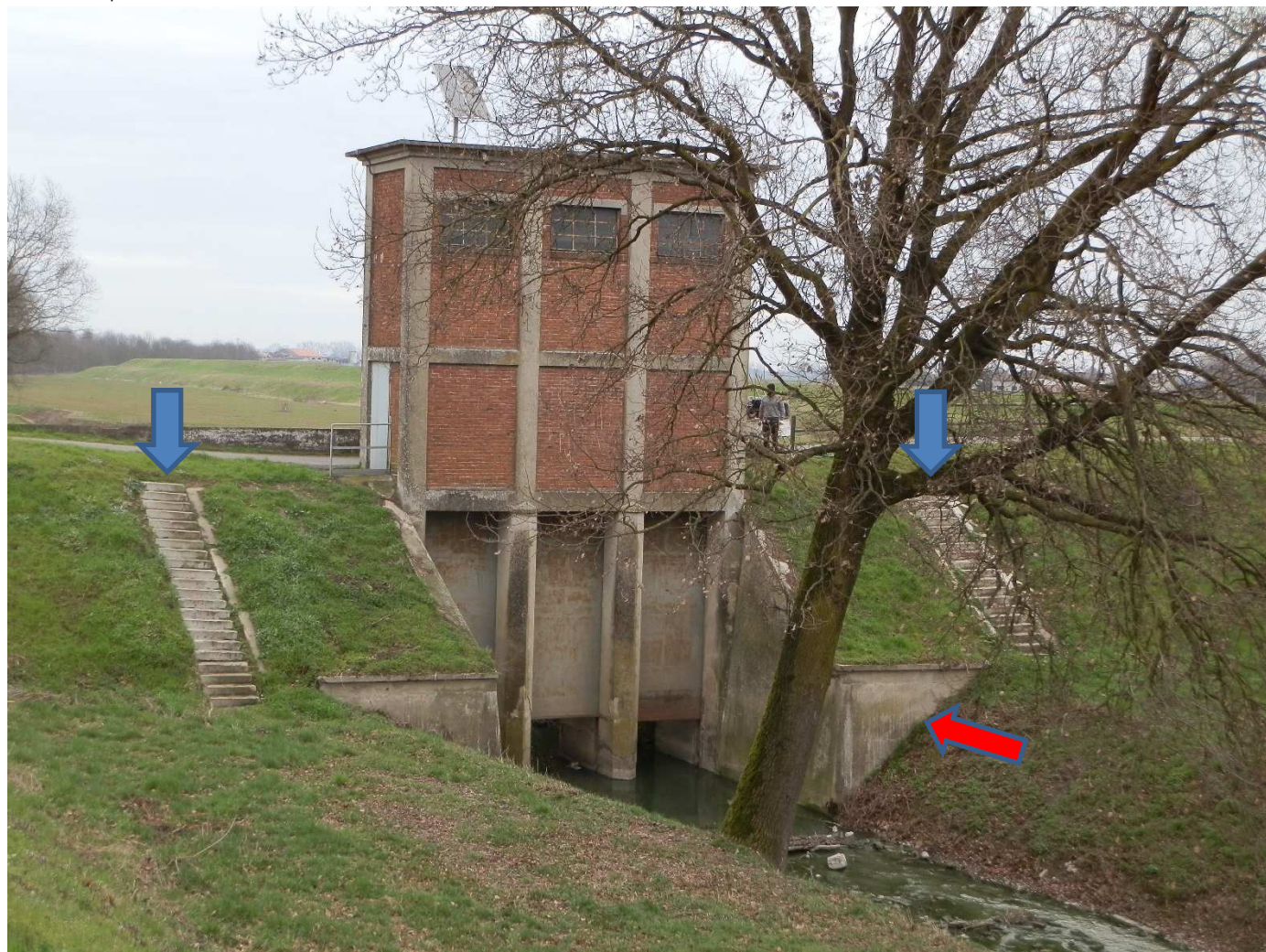
Figura 4: Ubicazione e tipologia delle scalette in c.a. di accesso al piano golenale
