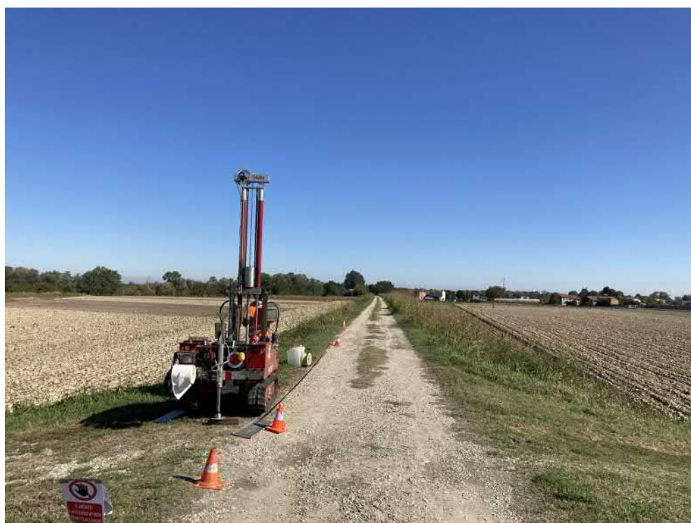
Esecuzione delle indagini penetrometriche
