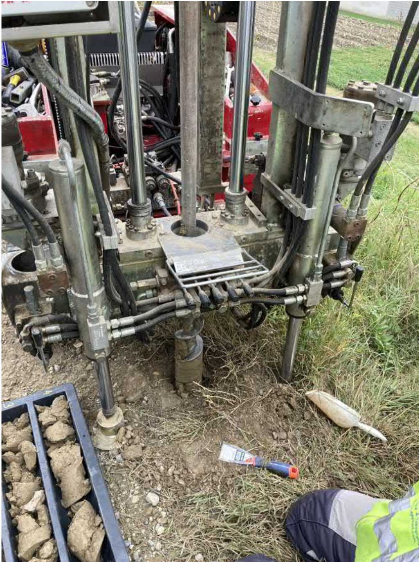
Carotaggio mediante sonda carotatrice con aste elicoidali
