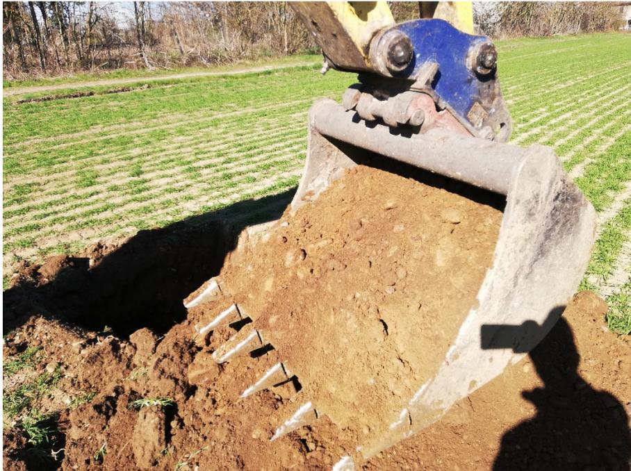
**Figura 2: Campionamento a mezzo di escavatore meccanico**
