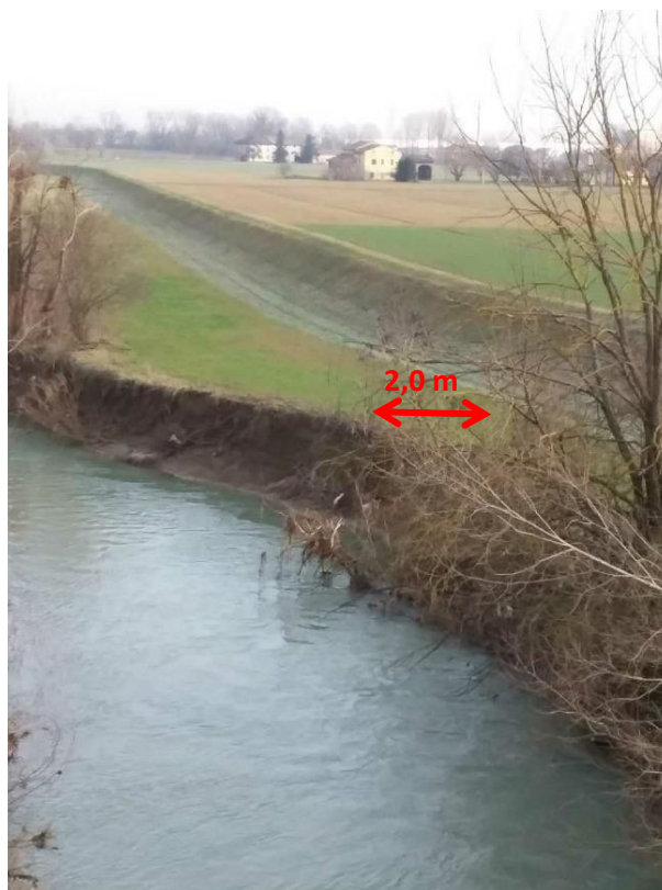
T. Stirone a valle del ponte Sigerico - erosione spondale in dx idraulica in con interessamento del piede arginale
