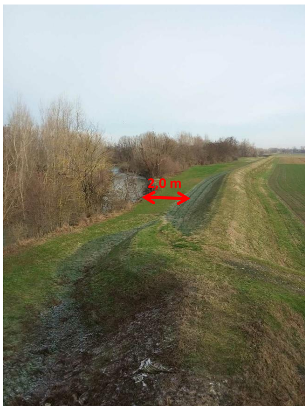
T. Stirone a valle del ponte Sigerico - erosione spondale in dx idraulica in con interessamento del piede arginale
