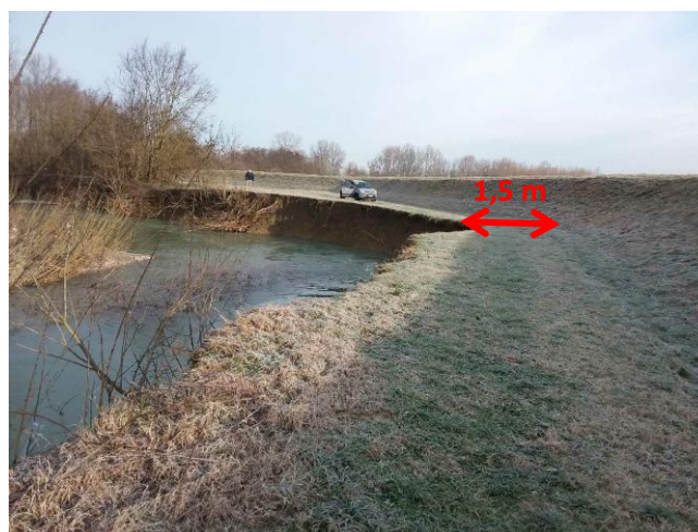
T. Stirone loc. S. Michele - erosione spondale in dx idraulica in con interessamento del piede arginale
