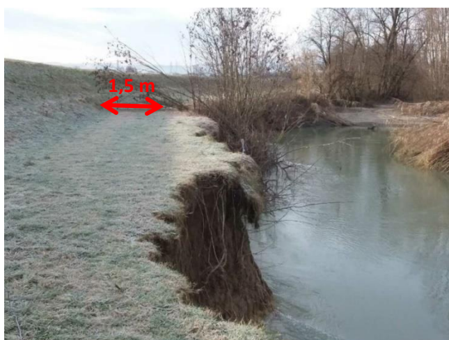
T. Stirone loc. S. Michele - erosione spondale in dx idraulica in con interessamento del piede arginale
