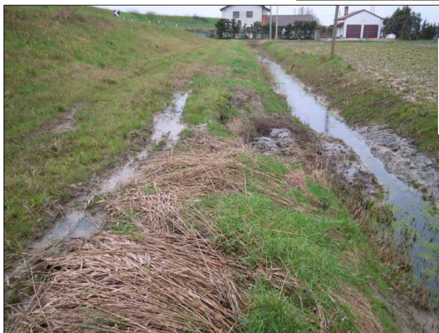
St. 15 - 2 a difesa a mare Bocca- sette-Cà Zuliani filtrazioni nella fascia di rispetto arginale
