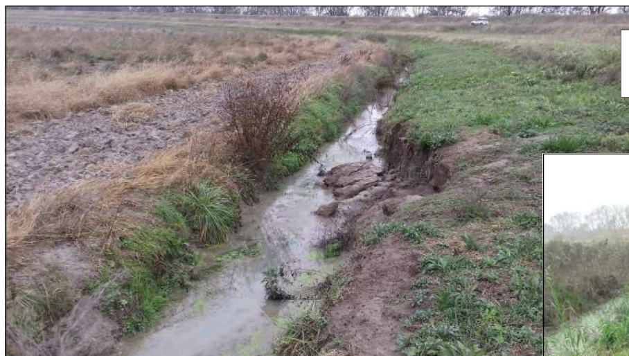
Filtrazioni e franamenti nella fascia di rispetto arginale
