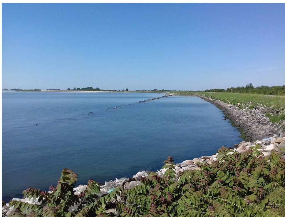
Fig. 9 – Vista pre-intervento del molo frangiflutti (molo n. 6) con punto di ripresa in direzione W-NW dall'argine di I linea della Sacca degli Scardovari; si nota la parziale sommersione in condizioni di marea
