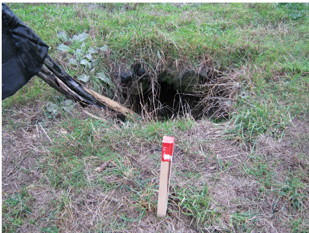
Fig. 10 – Cedimento della sommità arginale lungo l'argine di I linea della Sacca degli Scardovari; la criticità si manifesta tra stanti 93-105
