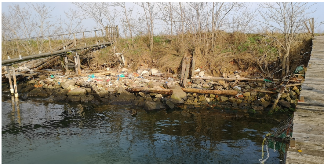
Figura 8 – Argine di I linea di difesa dal mare della Sacca degli Scardovari – particolare della scarpata arginale lato mare – in evidenza l'assenza del rivestimento in pietrame nella parte superiore della scarpata – stante 34-35 (lato est della Sacca).
