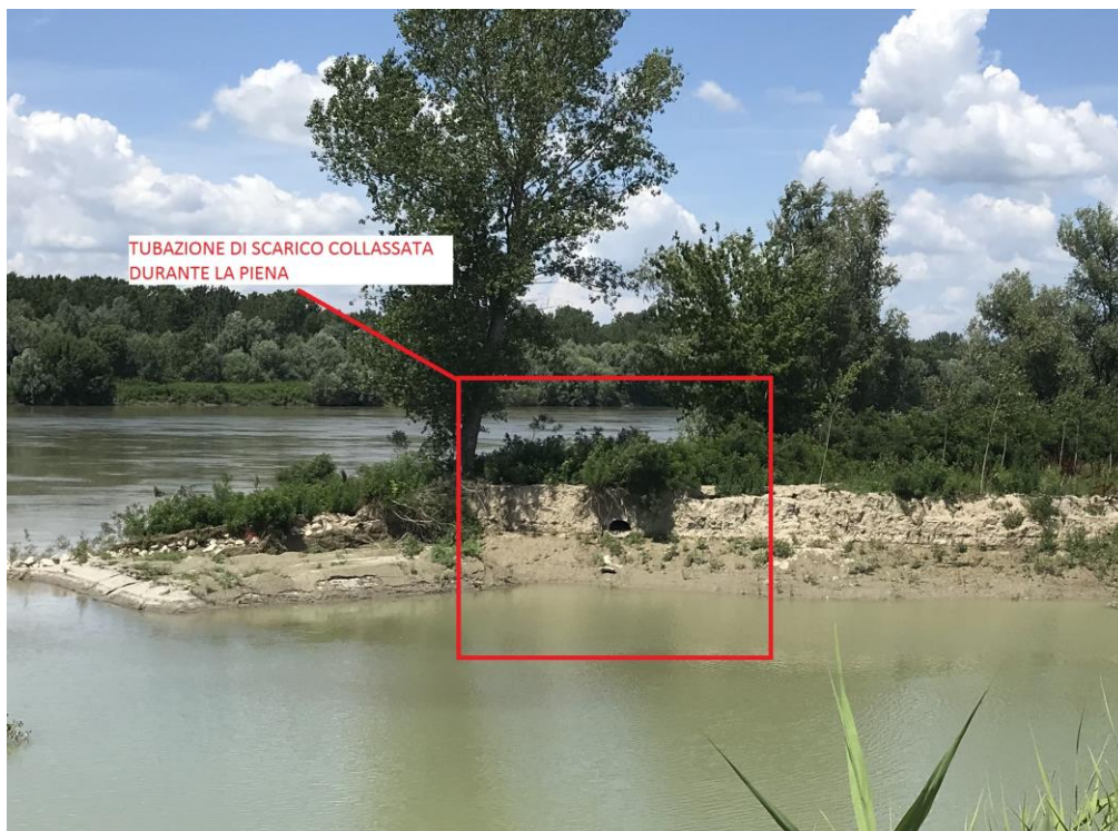
FIGURA 3-2 PARTICOLARE TUBAZIONE DI SCARICO
