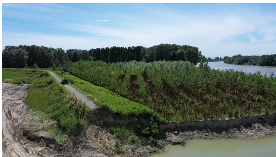
FIGURA 4-1 A) RIPRESA DEL BUDRIO E DELLA DIFESA DEL PENNELLO DI NAVIGAZIONE EROSA DURANTE LA PIENA; B) RIPRESA DELL'ARGINE GOLENALE COLLASSATO DURANTE LA PIENA (TRATTO OVEST)
