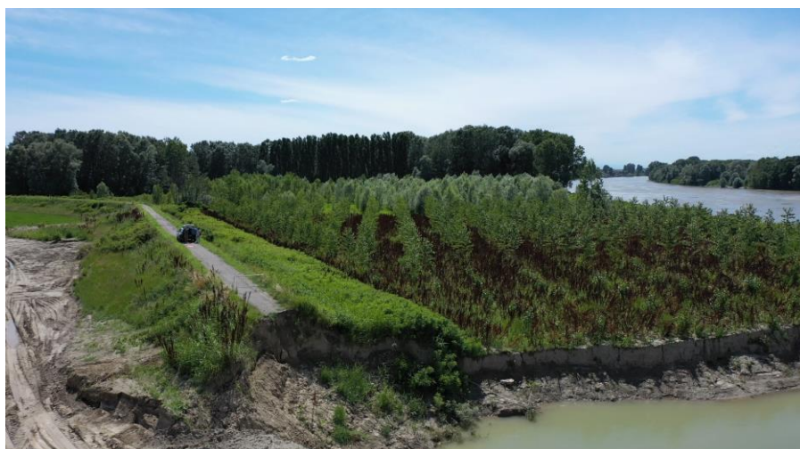
FIGURA 3-1 A) RIPRESA DEL BUDRIO E DELLA DIFESA DEL PENNELLO DI NAVIGAZIONE EROSA DURANTE LA PIENA; B) RIPRESA DELL'ARGINE GOLENALE COLLASSATO DURANTE LA PIENA (TRATTO OVEST)
