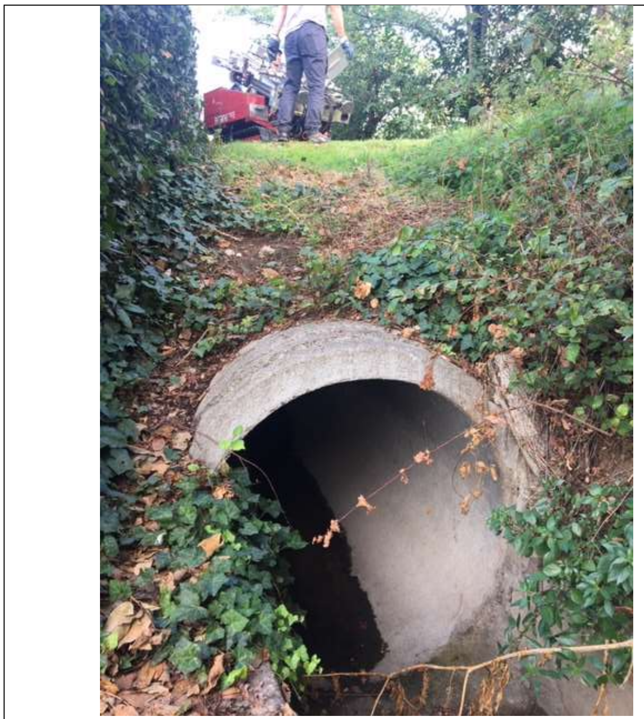
Figura 41 – Tubazione ricavata nel corpo arginale
