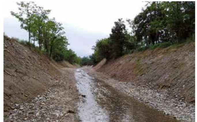
Riprofilatura e imbottimento di sponda ultimati
