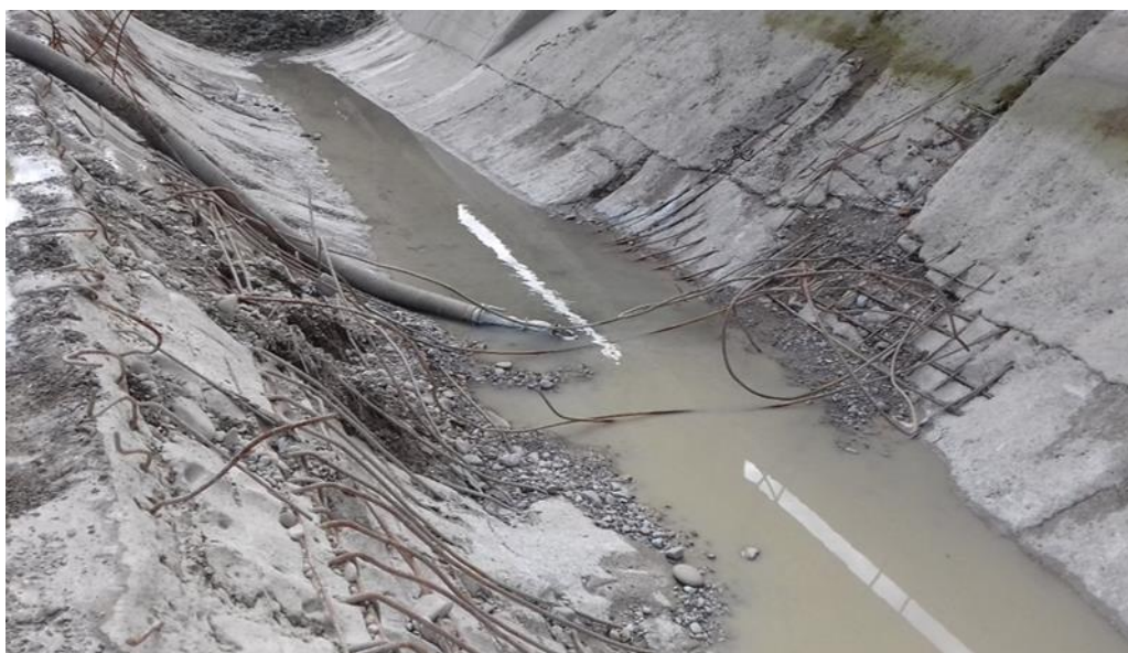
FIG. 3 – MANUFATTO LIMITATORE DI MONTE-ARMATURE SCALZATE DEL FONDO VASCA
