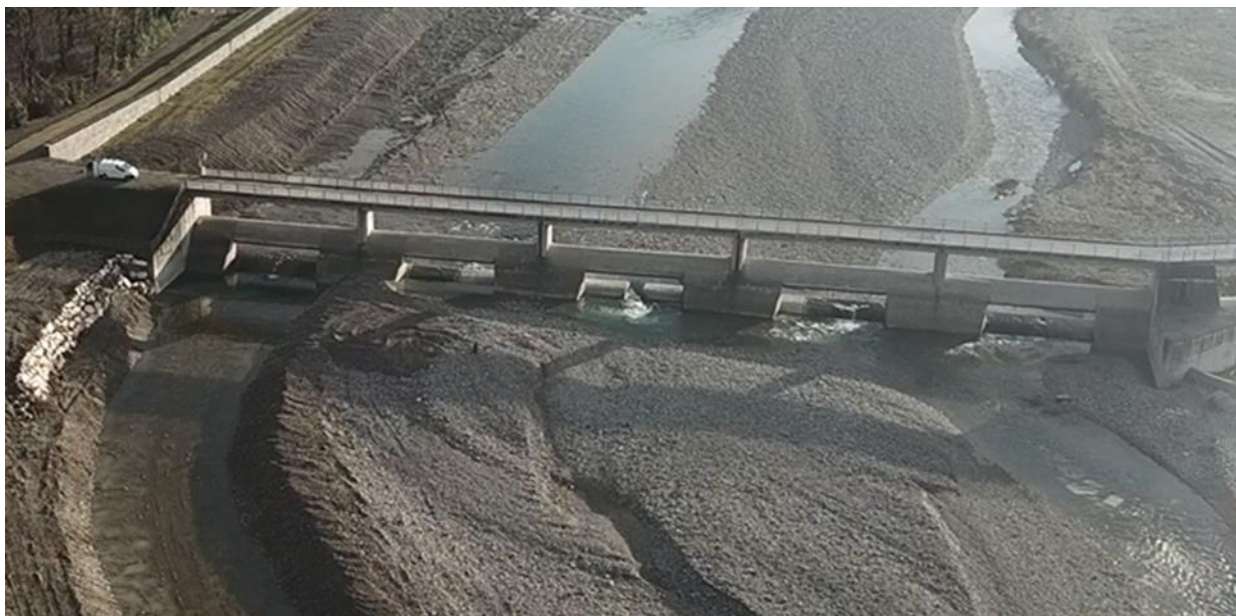
FIG. 2 – MANUFATTO LIMITATORE DI MONTE- TRATTA IN ALVEO
