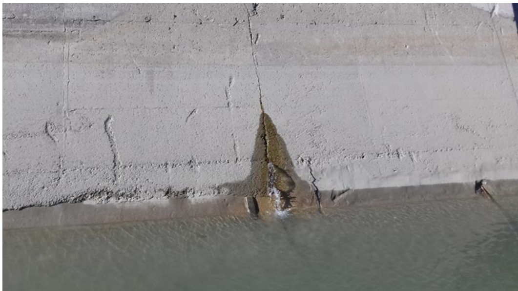
FIG. 4– MANUFATTO LIMITATORE DI MONTE- FILTRAZIONE D'ACQUA TRA I GIUNTI
