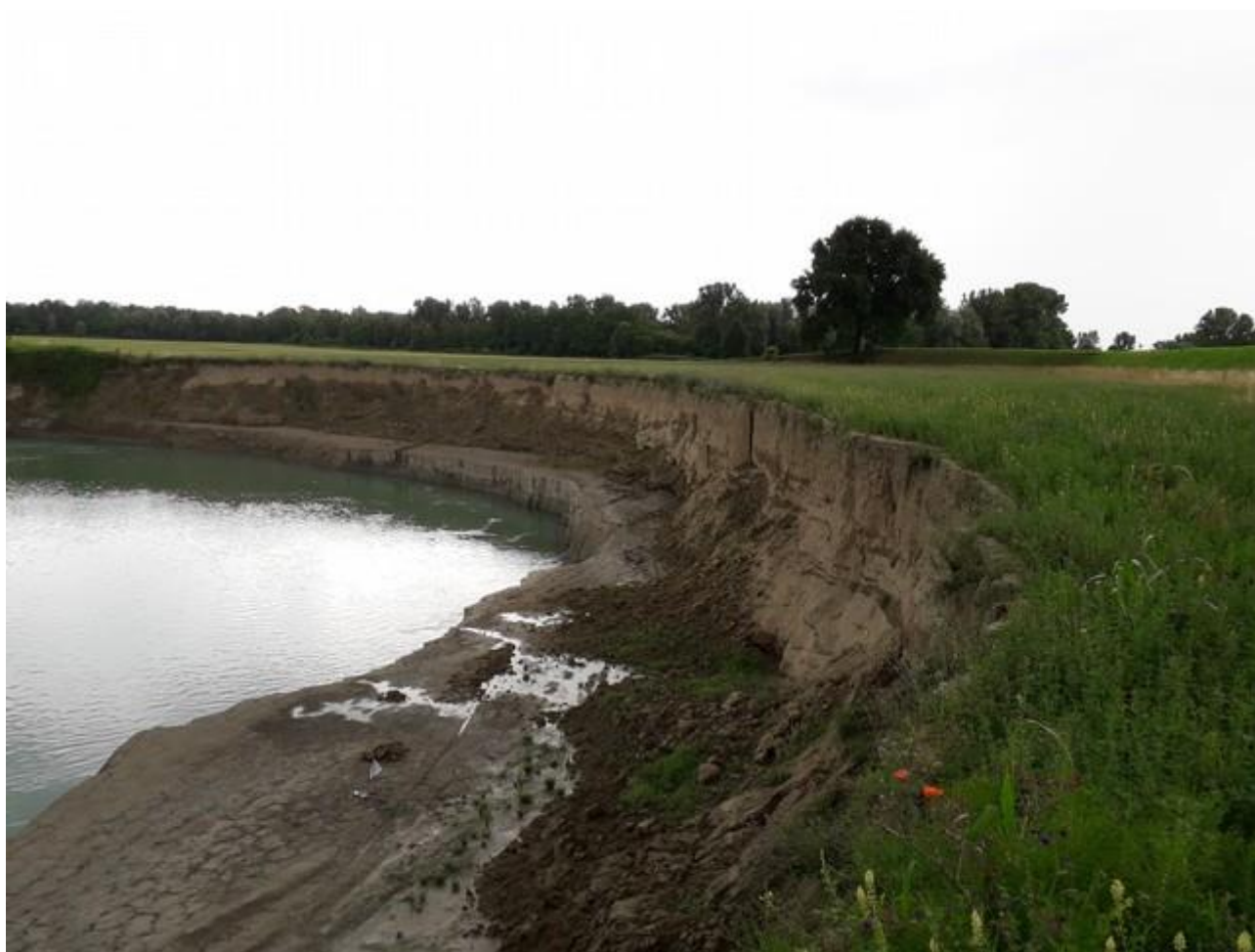
Fig 3. sponda in sinistra idraulica in forte erosione. In questo punto l'intera portata del fiume in magra è contenuta nel canale a ridosso sponda (parte a monte dell'area di intervento)
