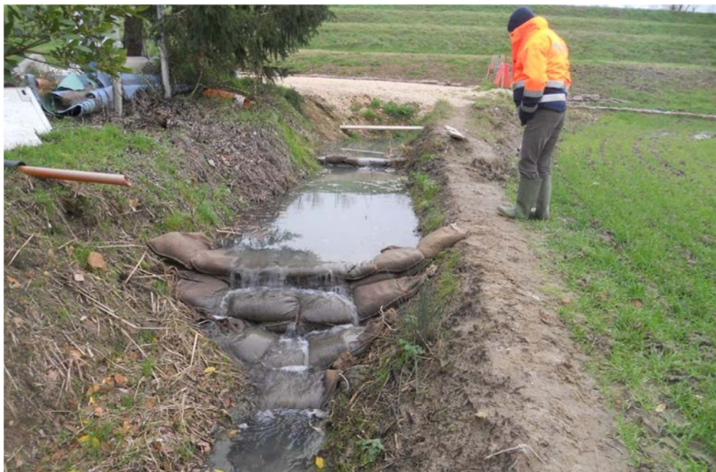
Figura 8 - Località Cavanella Po – Fine Dicembre 2019 – Nuova coronella di sacchetti nel fosso di scarico del drenaggio
