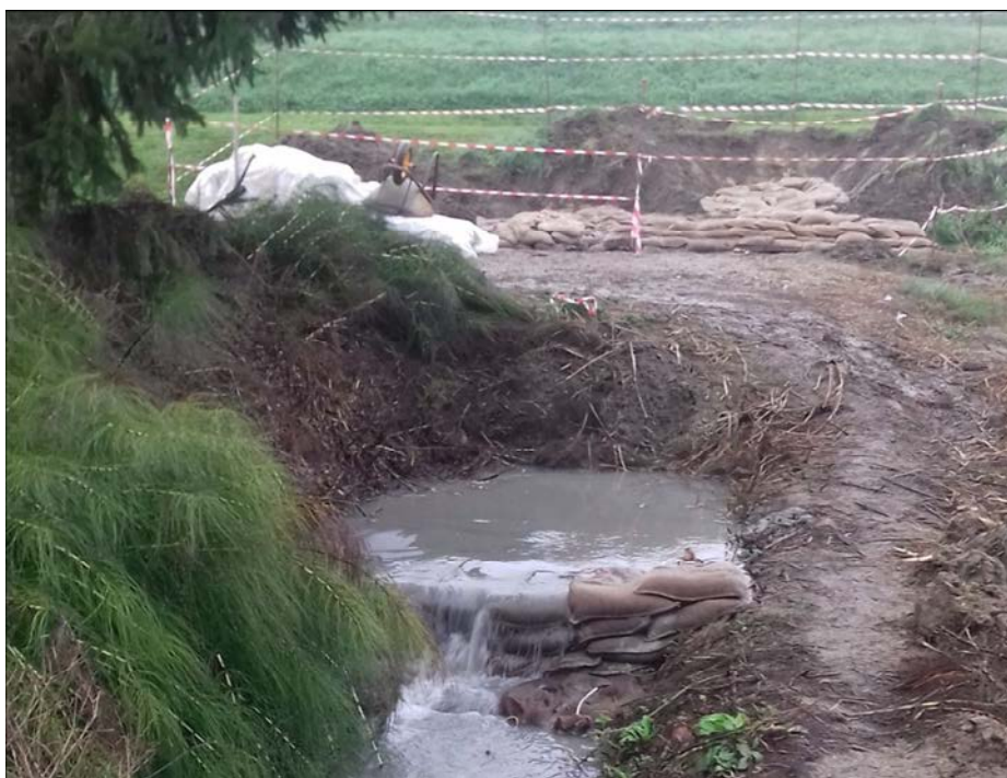
Figura 3 – Località Cavanella Po - Novembre 2018 - Coronella di sacchetti nel fosso di scarico del drenaggio, sullo sfondo è visibile il cedimento del piè di banca
