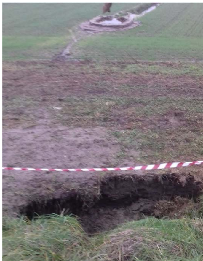
Figura 7 - Località Cavanella Po – Dicembre 2019 - Cedimento nel piè di banca
