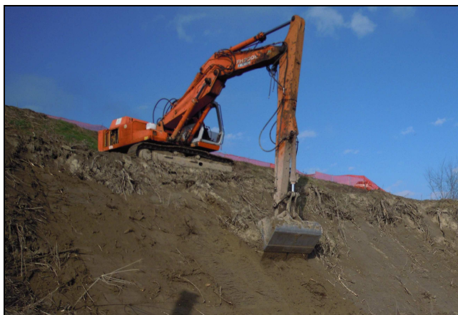
Immagine rappresentativa dell'attività di regolarizzazione della scarpata
