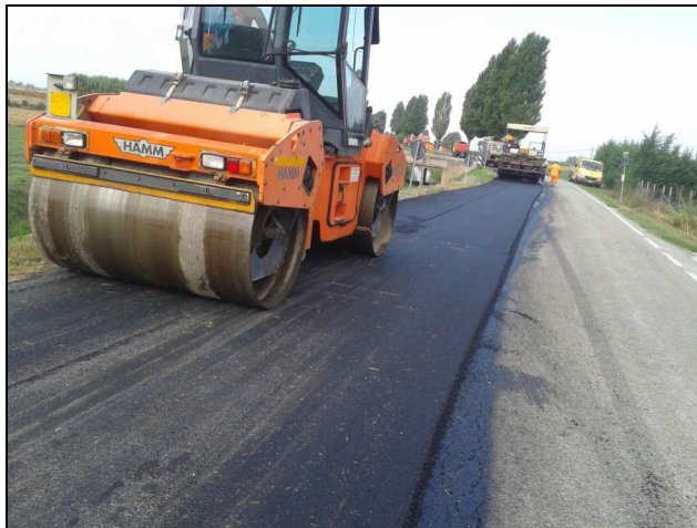
Immagine rappresentativa dell'attività di ripristino del manto bituminoso della pavimentazione stradale
